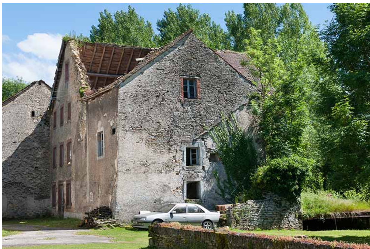
Le moulin depuis le nord-ouest.
