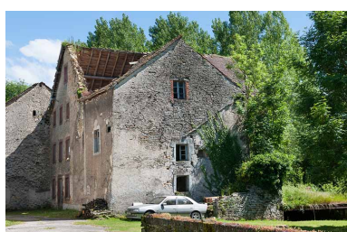
Le moulin depuis le nord-ouest. Phot. Jérôme Mongreville IVR43_20132500643NUC4A
