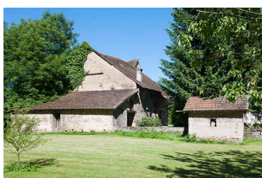
Dépendance vue depuis l'est. Phot. Jérôme Mongreville IVR43_20132500641NUC4A
