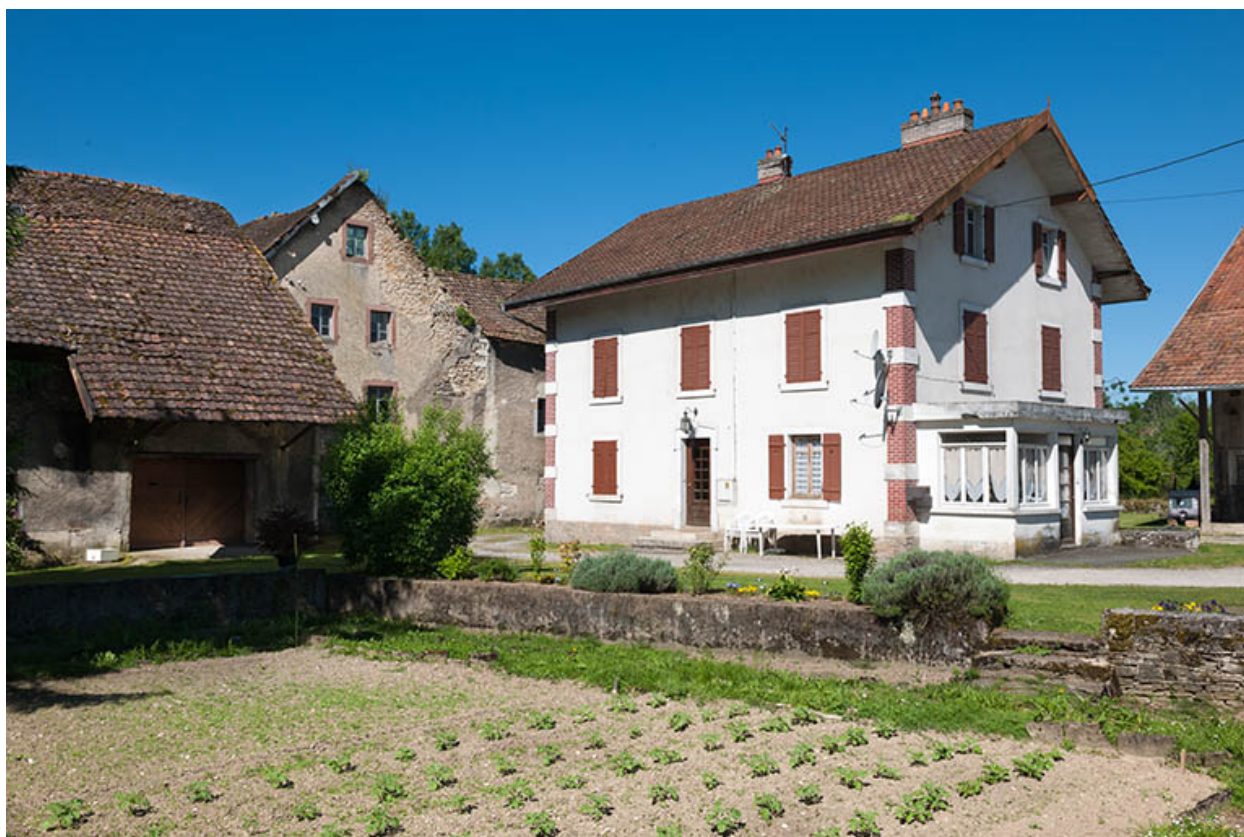
Moulin et logement vus depuis l'est.
