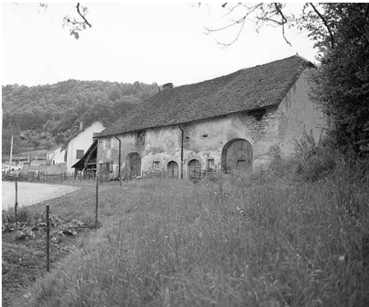
Ferme située rue Saint-Vincent.
