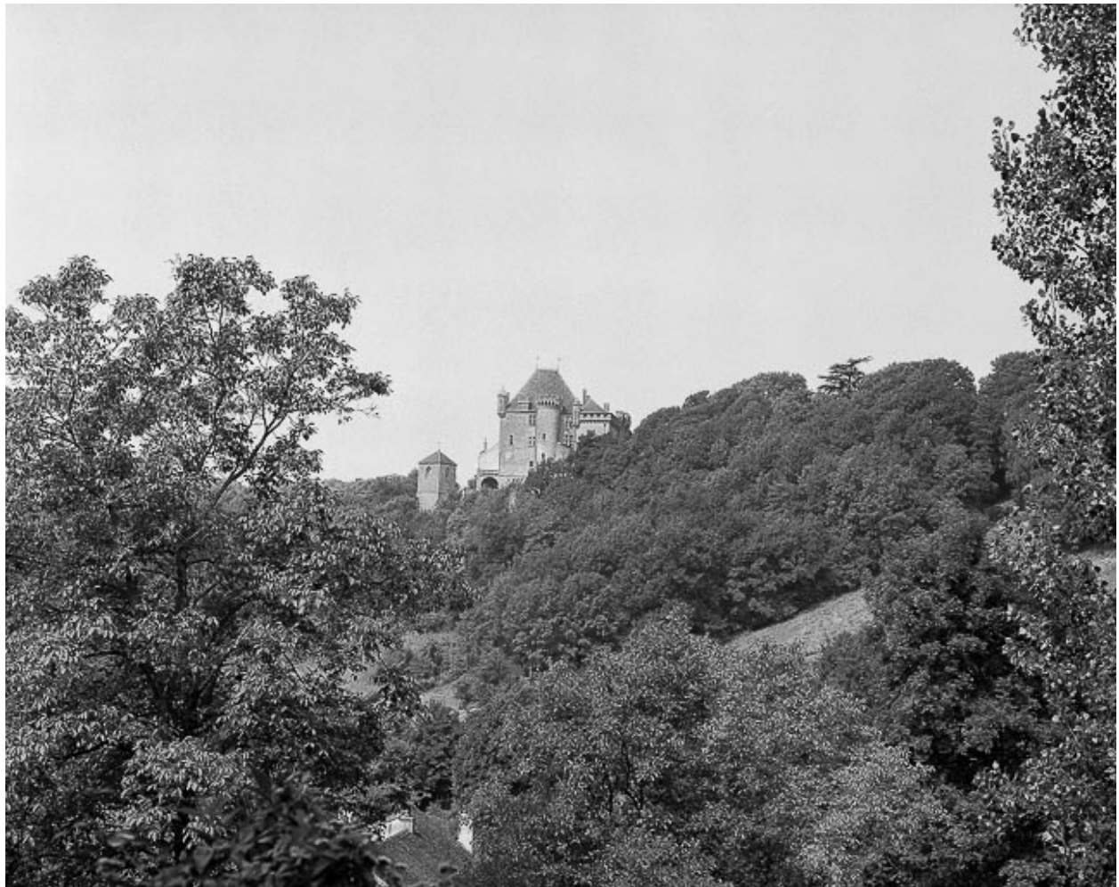
Le château fort vu depuis le sud.
