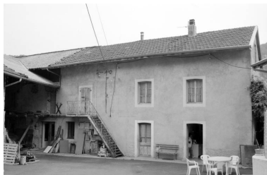
Façade antérieure du logement. Phot. Laurent Poupard IVR43_19933900513Z
