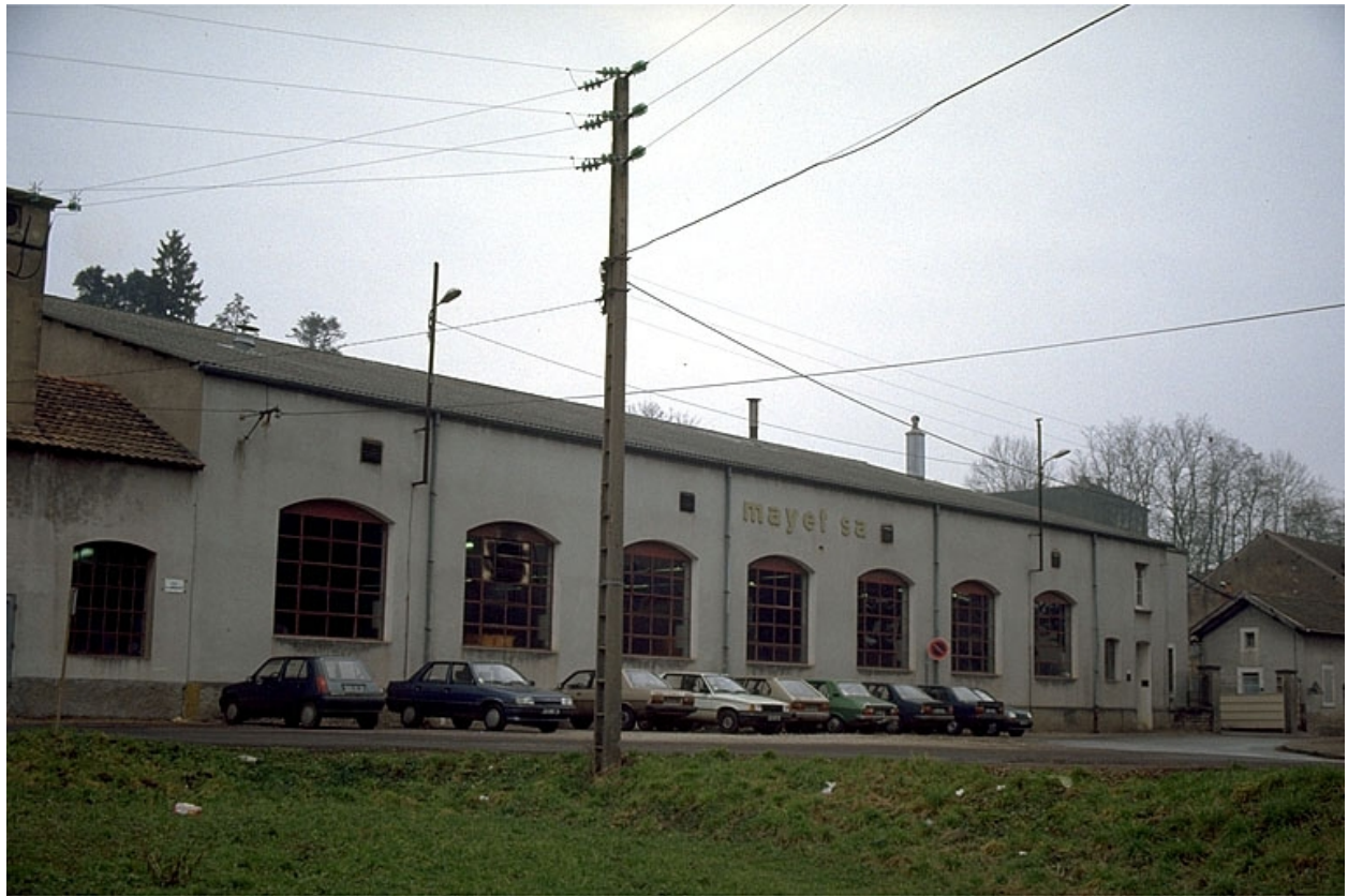
Façade antérieure de l'atelier de fabrication.
