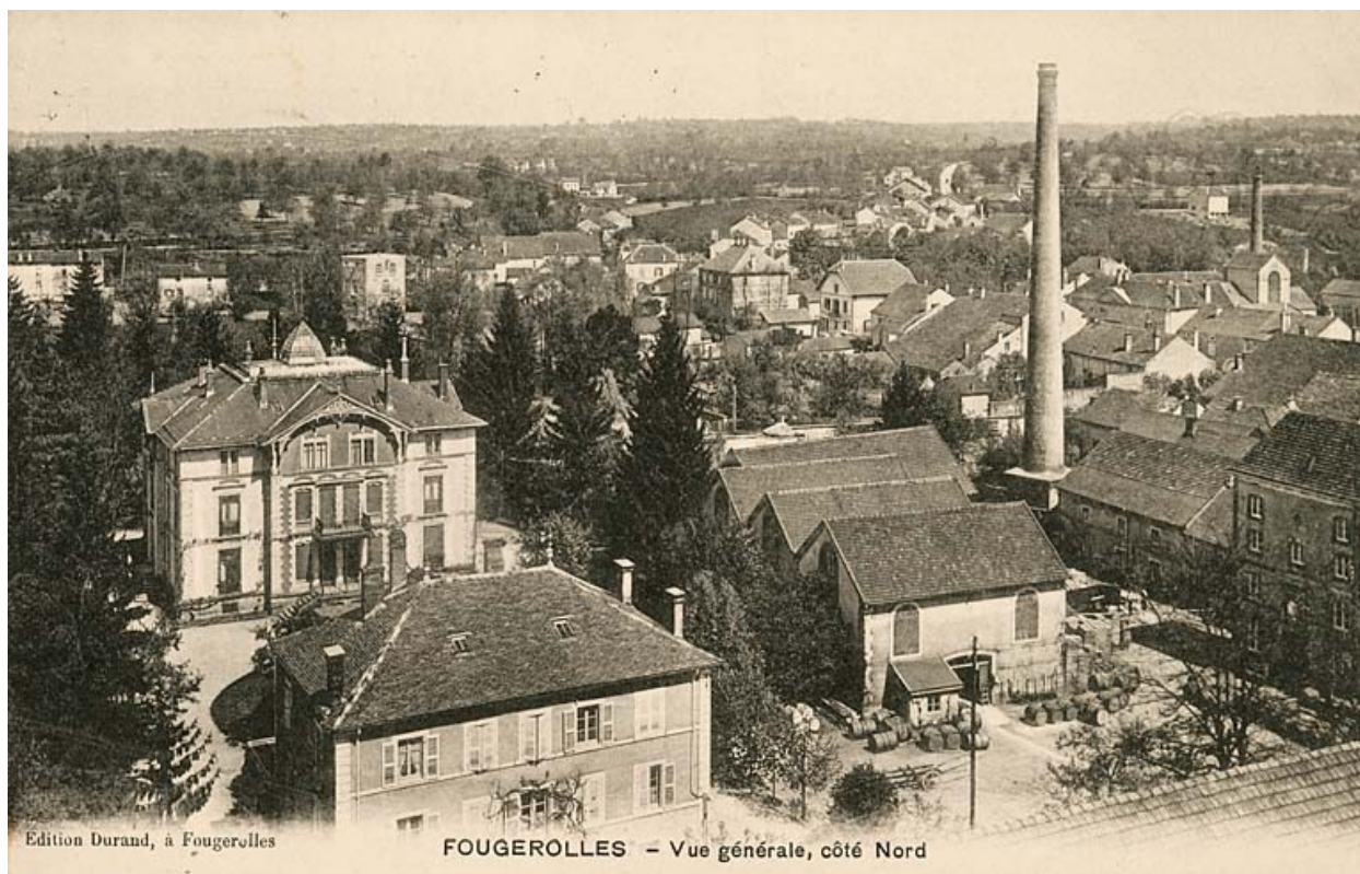
Fougerolles. Vue générale côté nord.
