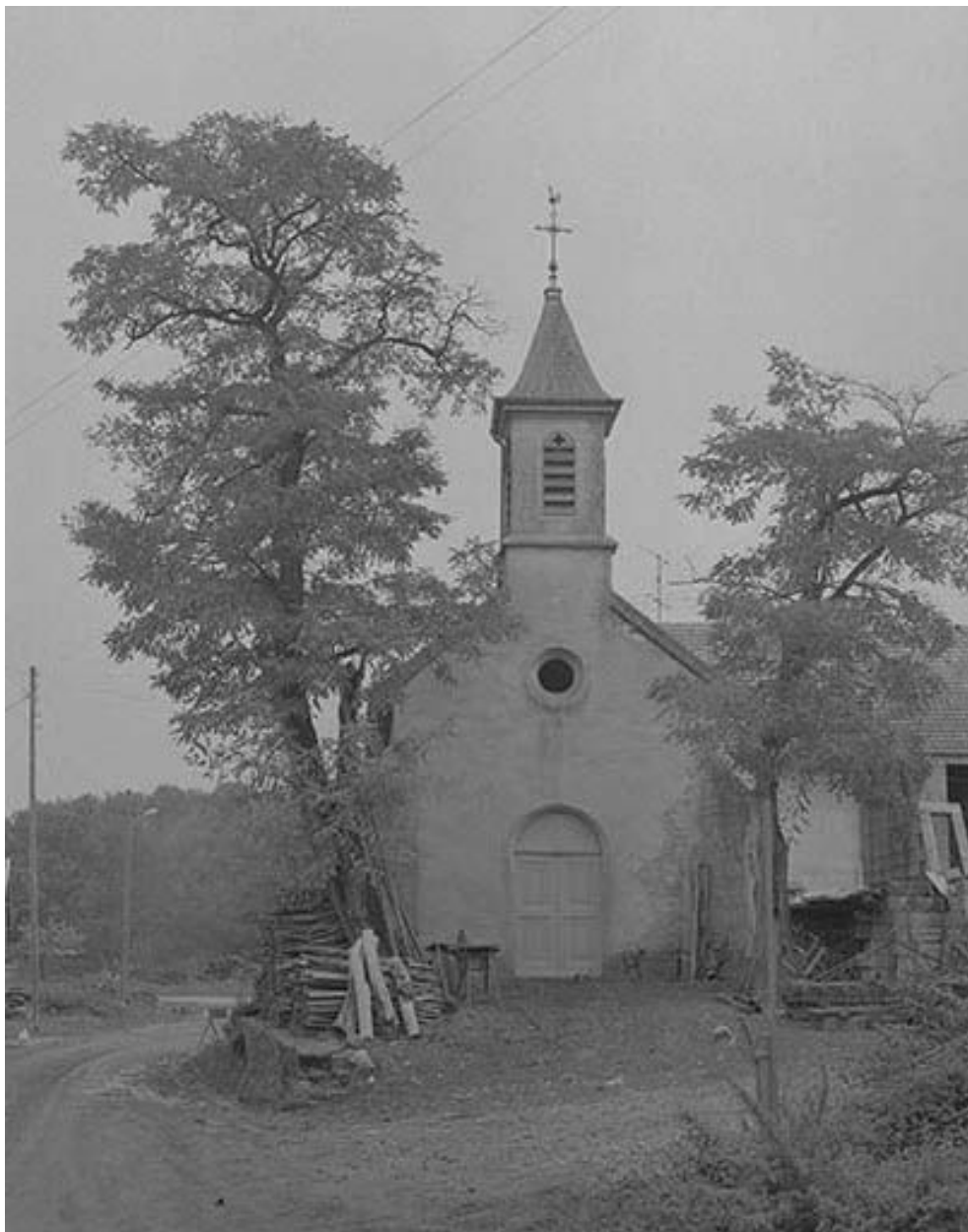
Extérieur : façade antérieure.
