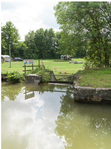
Vue du déversoir de superficie. Phot. Pierre-Marie Barbe-Richaud IVR26_20175800327NUC2A
