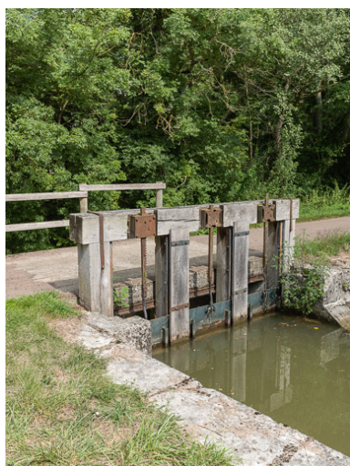
Le déversoir de fond, côté canal. Phot. Pierre-Marie Barbe-Richaud IVR26_20175800329NUC2A
