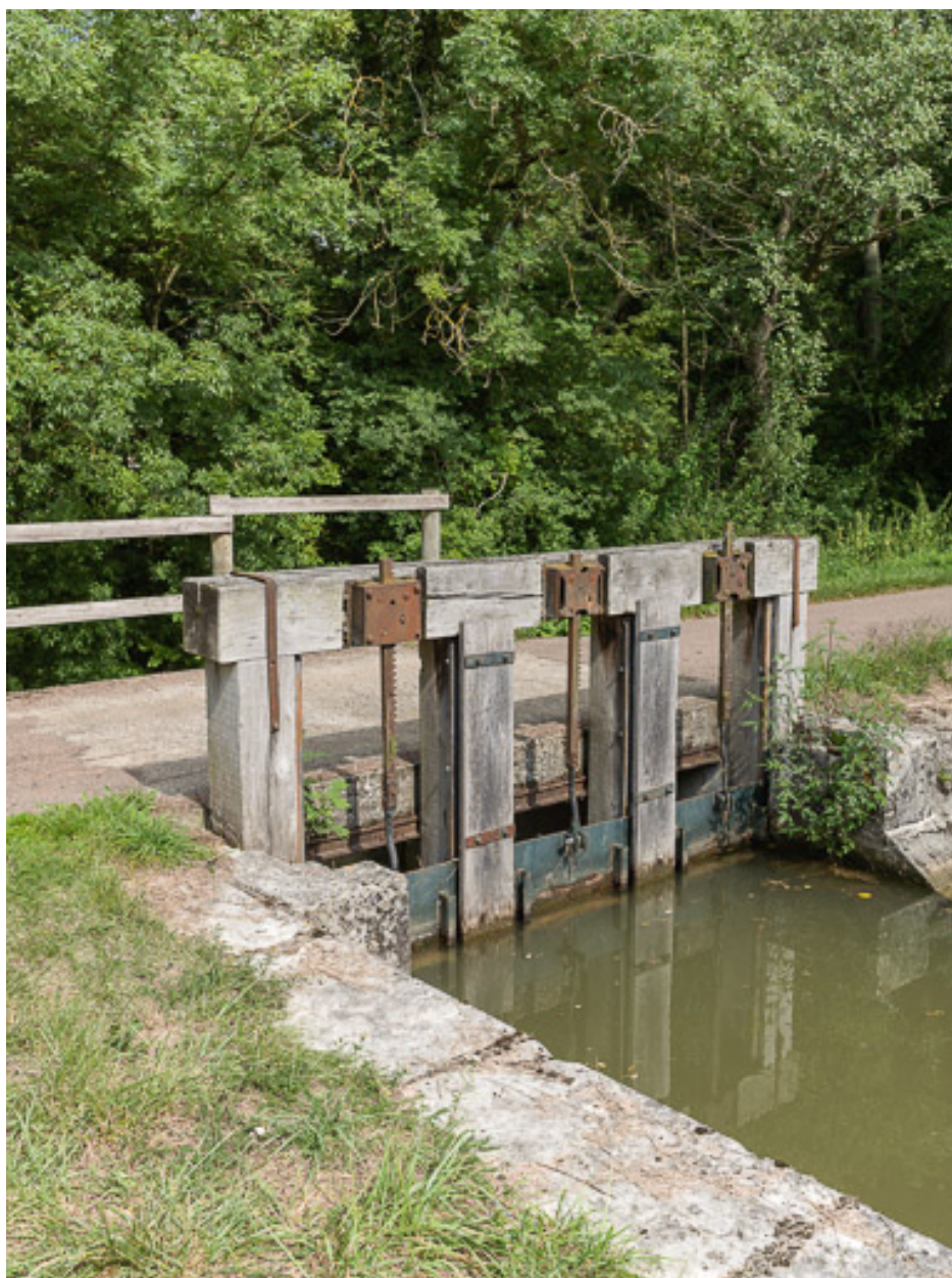
Le déversoir de fond, côté canal.
