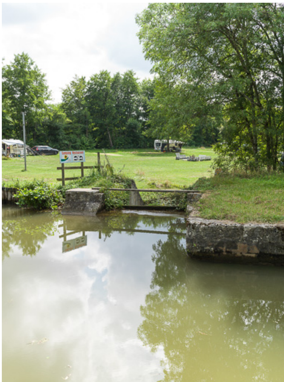
Vue du déversoir de superficie.
