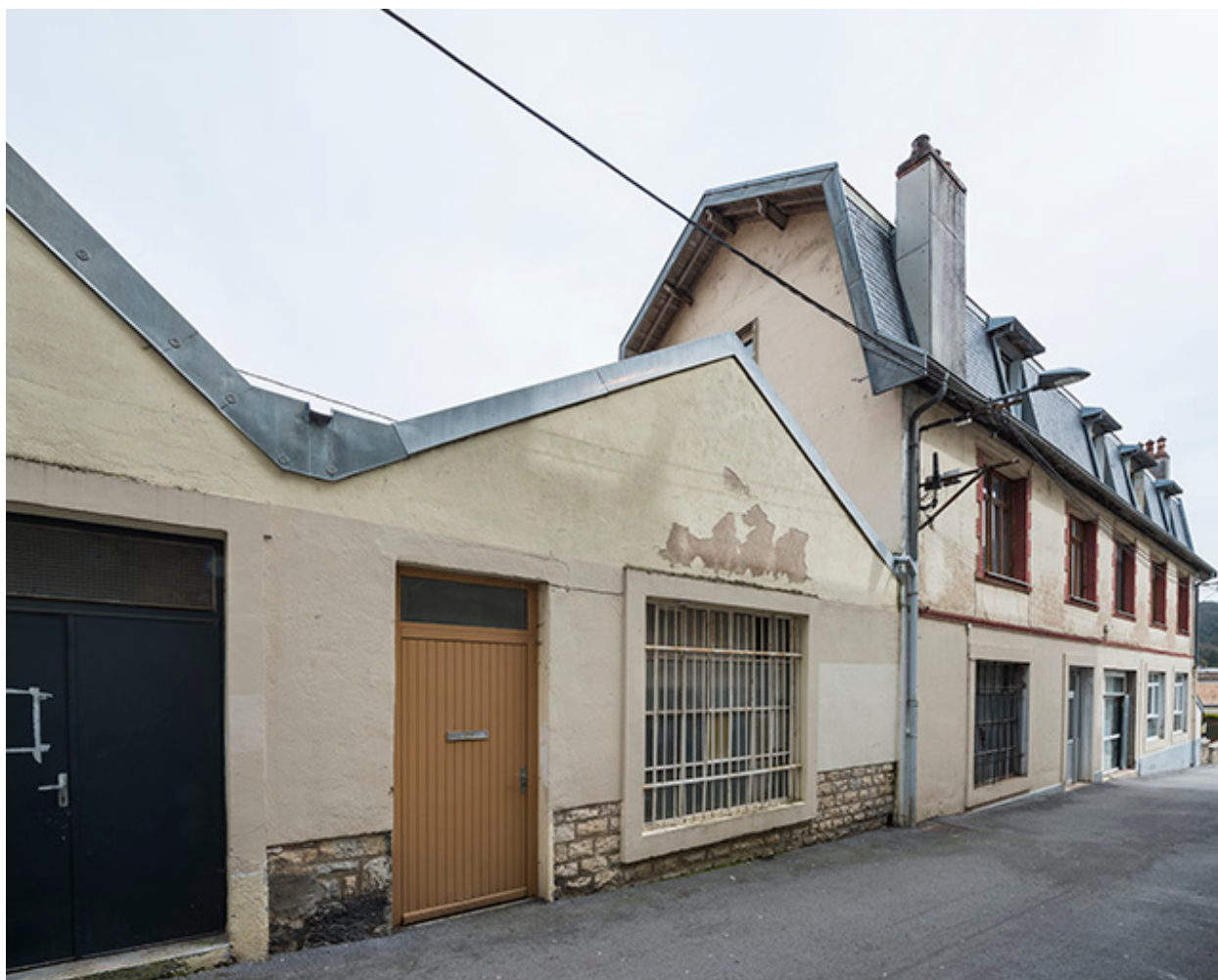
Atelier depuis le nord-ouest.
