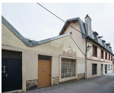
Atelier depuis le nord-ouest. Phot. Jérôme Mongreville IVR43_20182500601NUC4A
