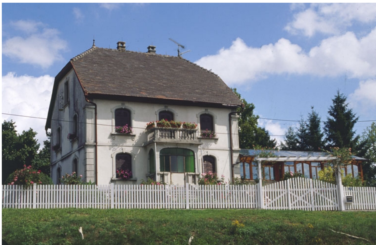
Le logement patronal.
