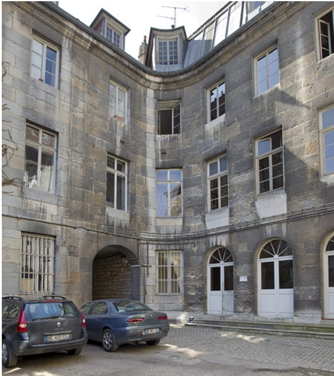
Logis principal : angle des facades sur cour.
