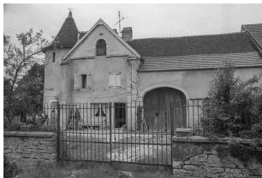
Façade antérieure depuis la cour. Phot. Bernard Lardière IVR43_19817000384Z
