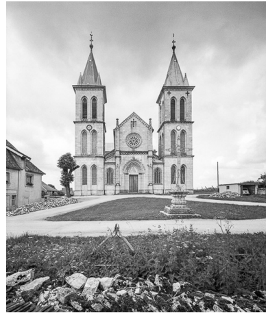
Façade antérieure. Phot. Yves Sancey IVR43_19752500289V
