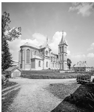
Façade latérale gauche et chevet. Phot. Yves Sancey IVR43_19752500290V
