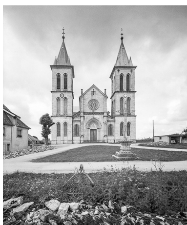
Façade antérieure. Phot. Yves Sancey IVR43_19752500289V
