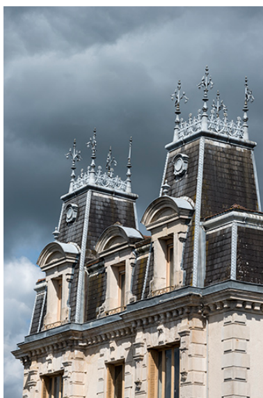
Toiture, côté sud. Phot. Jérôme Mongreville IVR43_20187000466NUC4A
