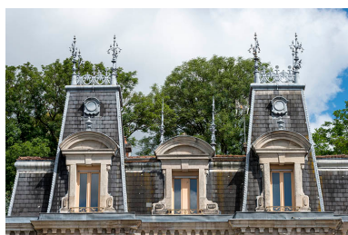
Toiture, côté sud. Phot. Jérôme Mongreville IVR43_20187000467NUC4A
