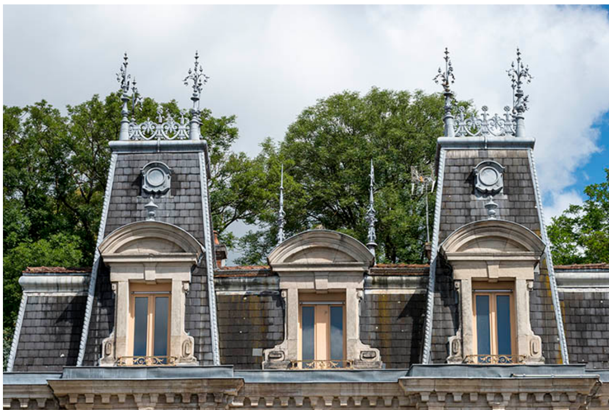
Toiture, côté sud.
