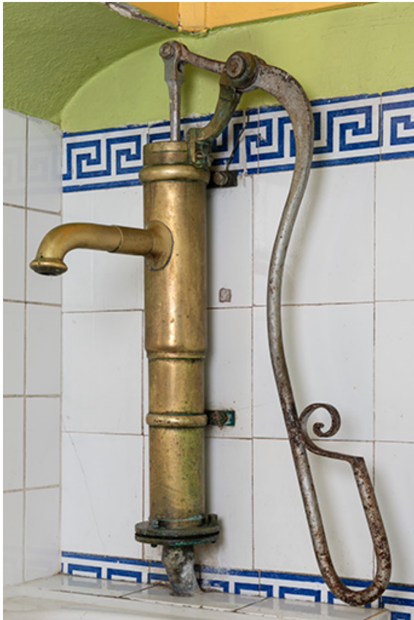
Rez-de-chaussée, cuisine, pompe à main.
