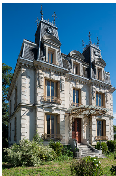
Façade antérieure. Phot. Jérôme Mongreville IVR43_20187000475NUC4A
