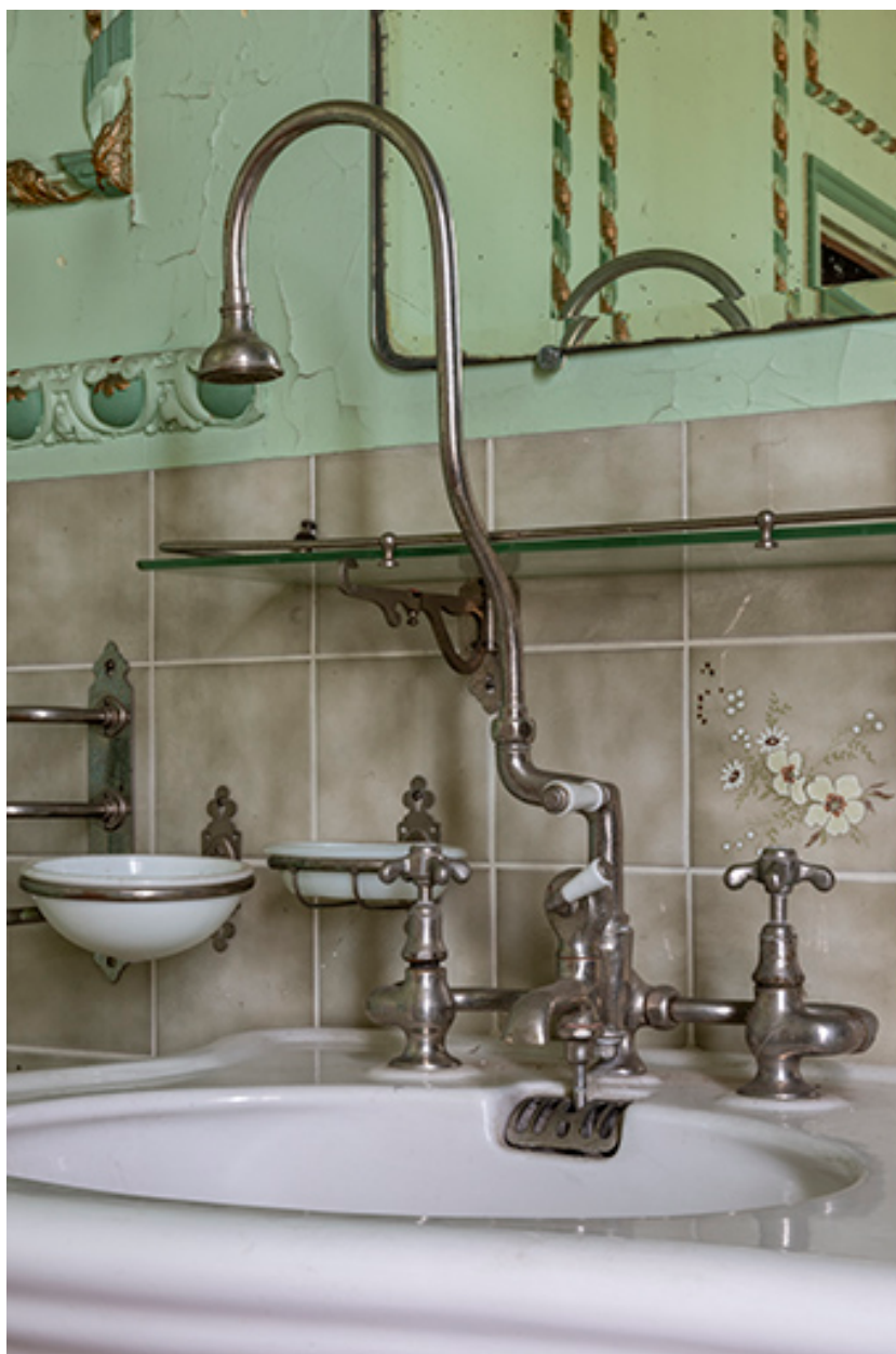
Premier étage, salle d'eau, robinets.
