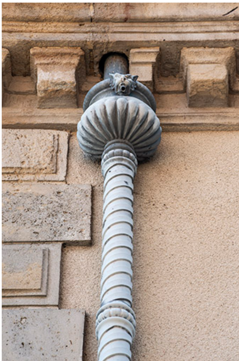
Descente d'eau en hélice avec cuvette godronnée.
