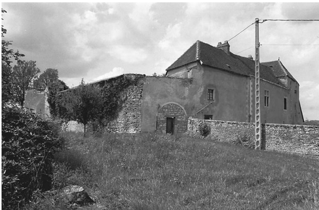
Façades postérieure et latérale droite.
