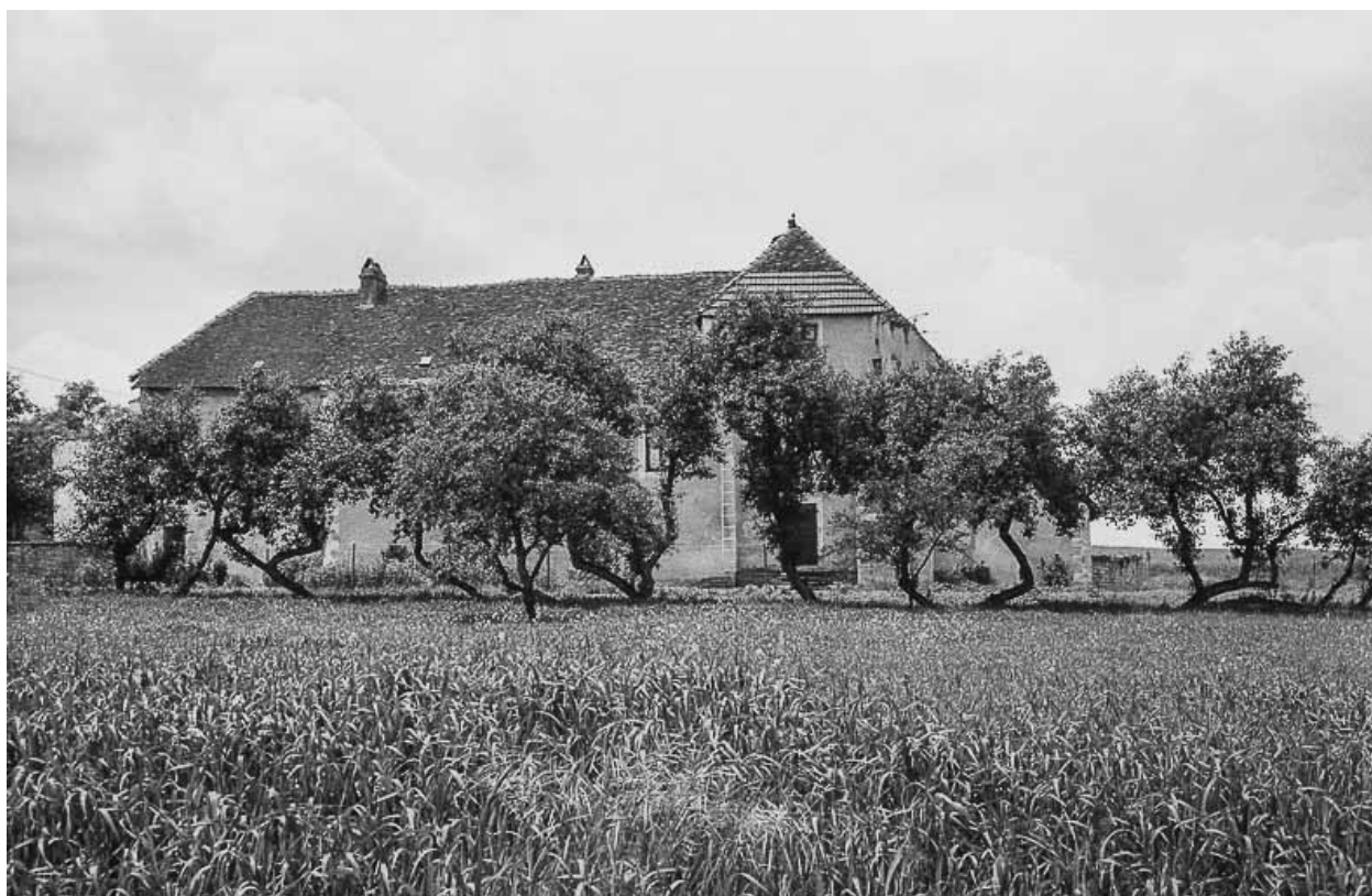
Façade postérieure du bâtiment.
