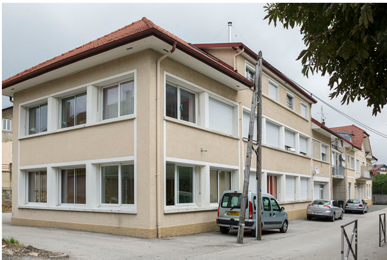
Façades latérale gauche et antérieure.
