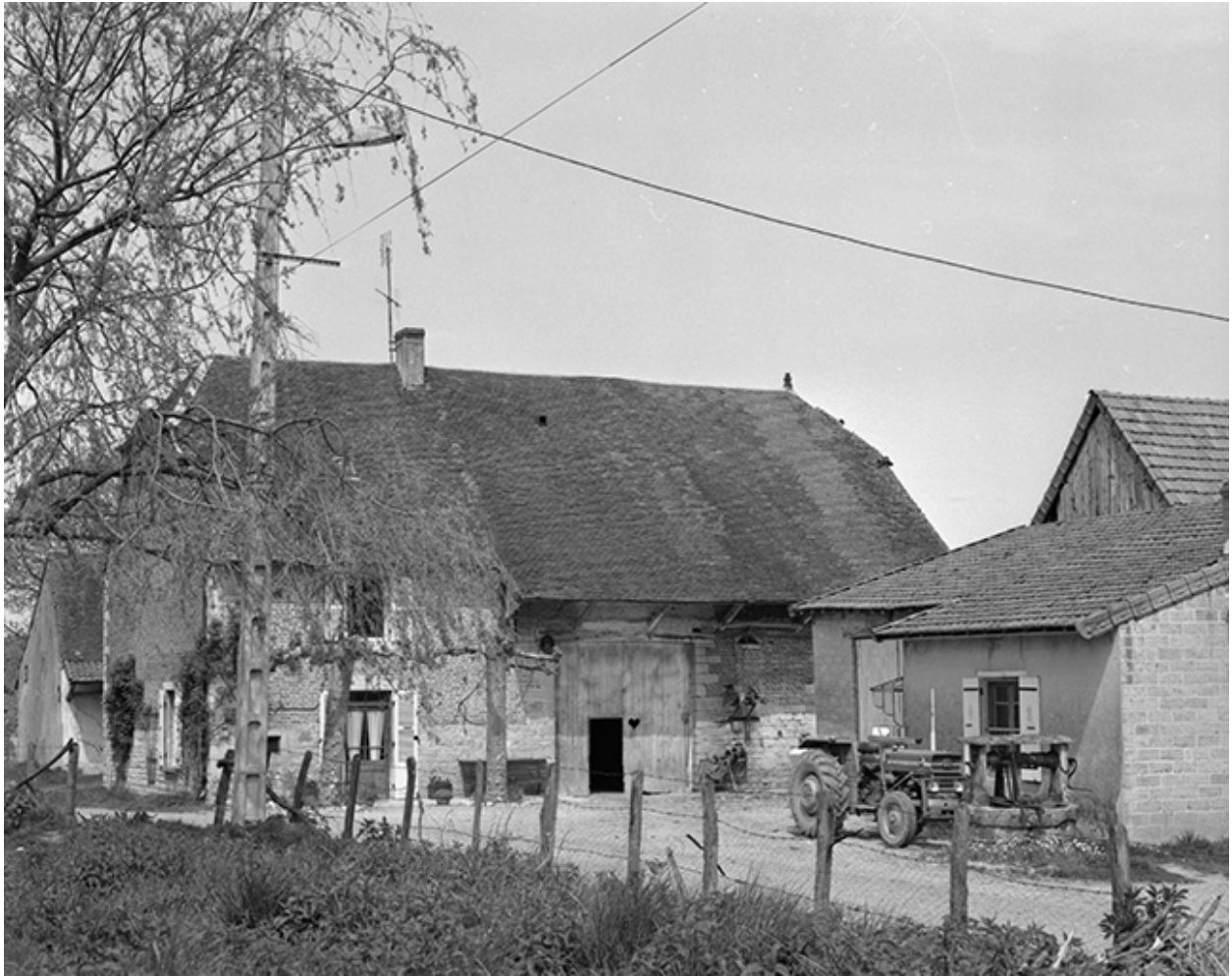
Façade antérieure et bâtiment agricole.
