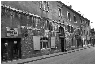
Façade sur la rue Montrieux.
