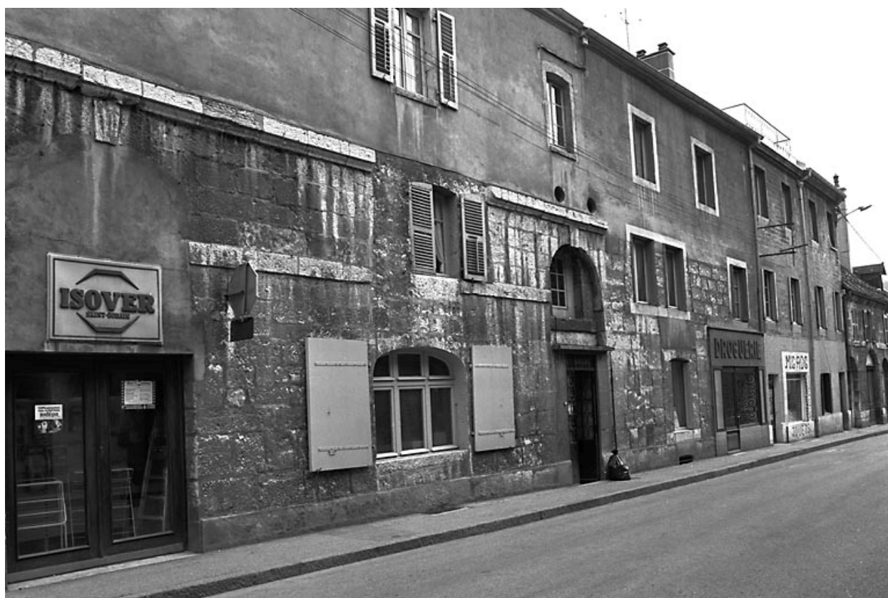
Façade sur la rue Montrieux.
