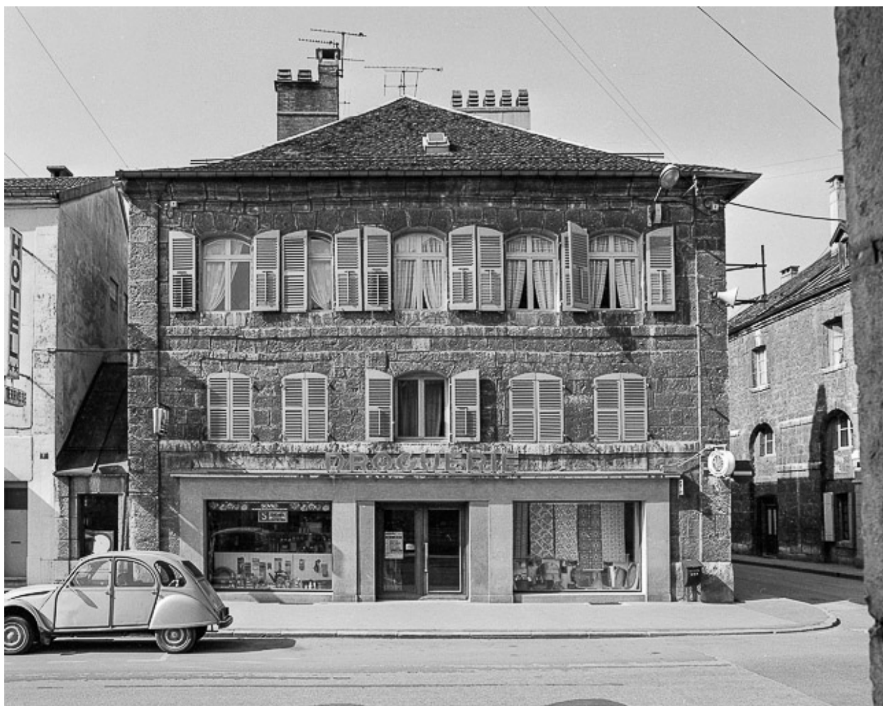
Façade sur la rue de la République, vue de face.
