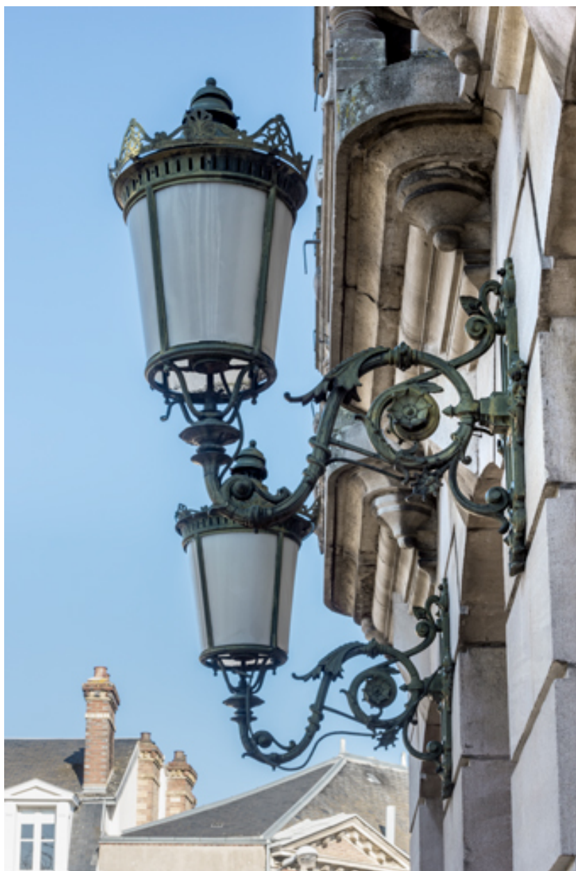
Luminaires d'applique en façade, vus de profil.
