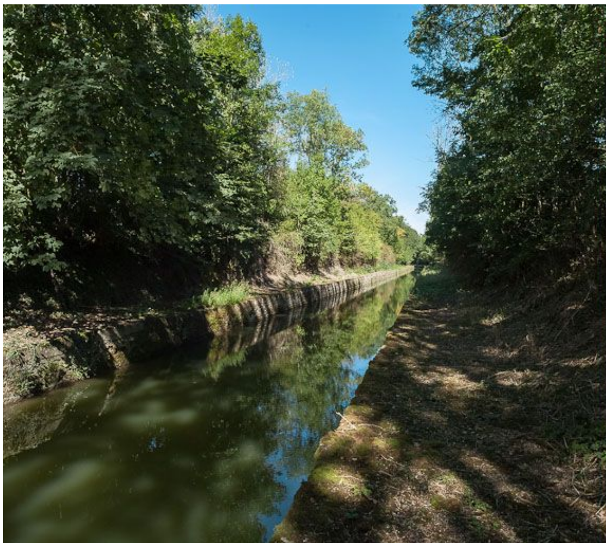
Vue d'ensemble de la tranchée.
