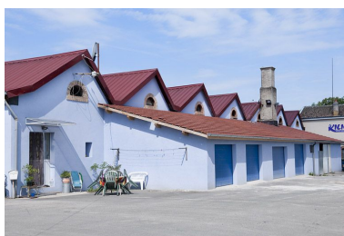
Pignons de l'atelier de fabrication. Phot. Jérôme Mongreville IVR43_20112501226NUC4A
