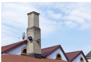
Détail de la cheminée de l'ancienne chaufferie. Phot. Jérôme Mongreville IVR43_20112501229NUC4A
