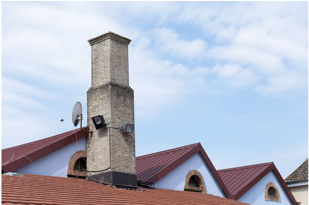
Détail de la cheminée de l'ancienne chaufferie.
