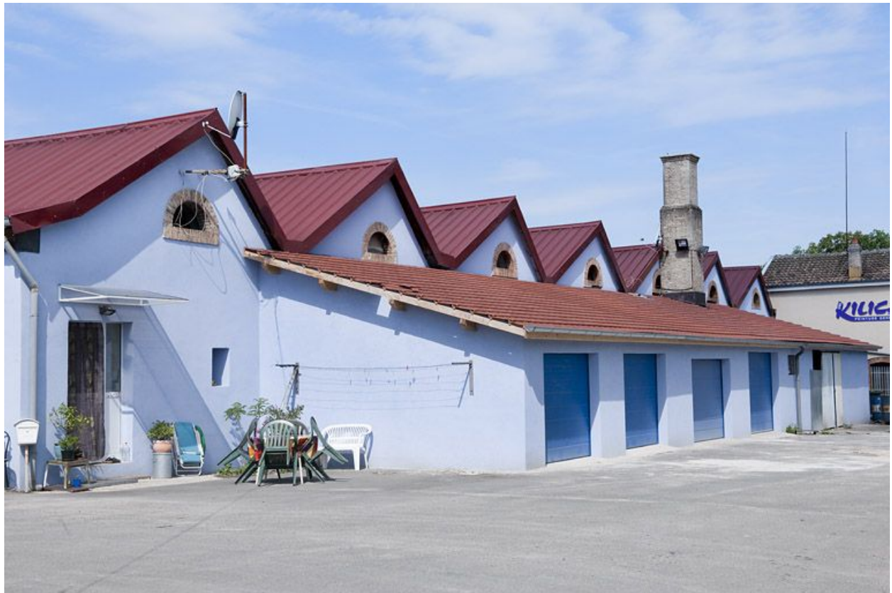
Pignons de l'atelier de fabrication.
