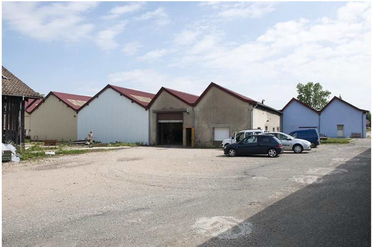
Pignons sud de l'atelier de fabrication.
