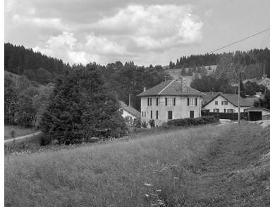
Vue de situation. Phot. Jérôme Mongreville IVR43_20003900313X
