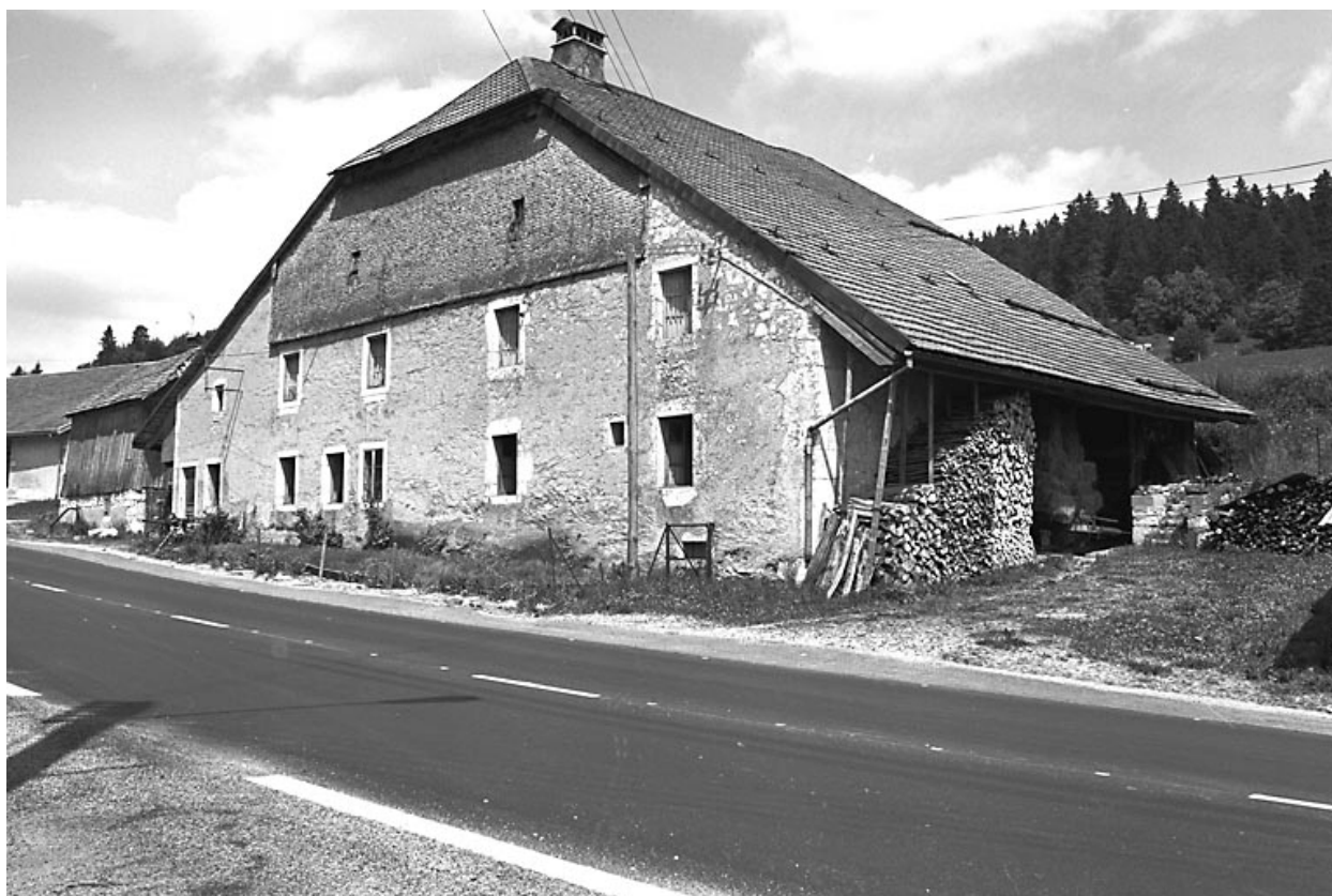
Ferme située impasse de la Source (?).
