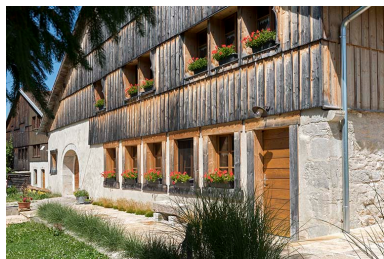
Façade antérieure, vue en enfilade. Phot. Sonia Dourlot IVR43_20172500704NUC4A
