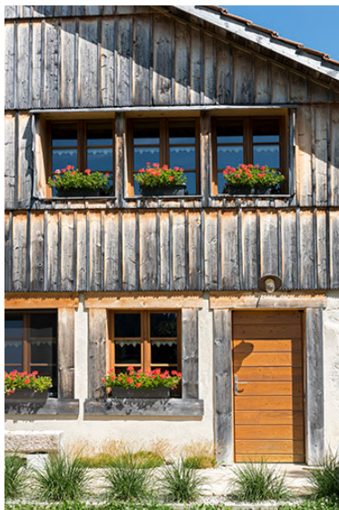
Façade antérieure : fenêtre multiple. Phot. Sonia Dourlot IVR43_20172500705NUC4A
