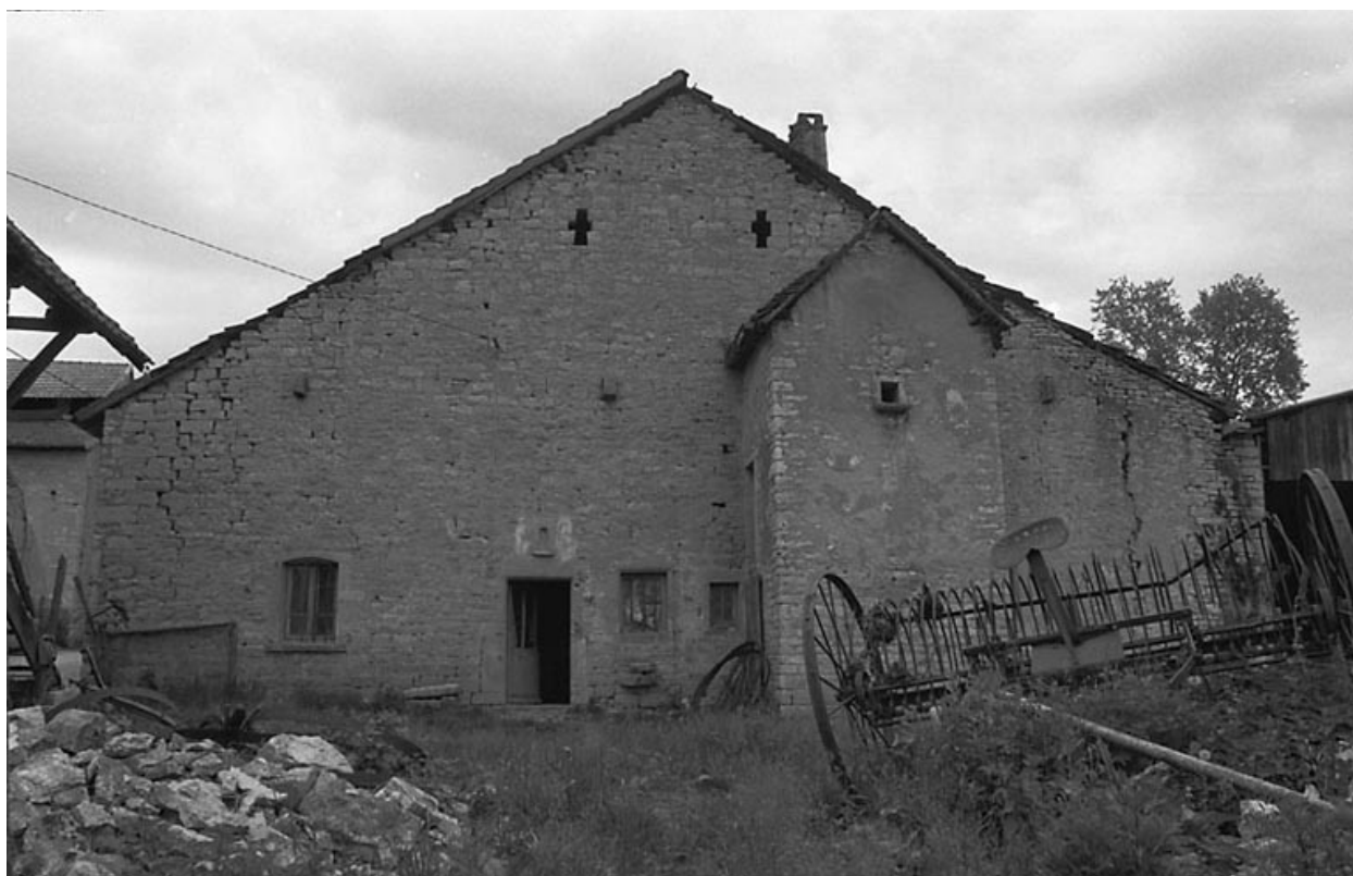
Façade antérieure sur cour.
