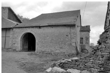
Façade latérale gauche sur rue. Phot. Bernard Lardière IVR43_19817000544Z
