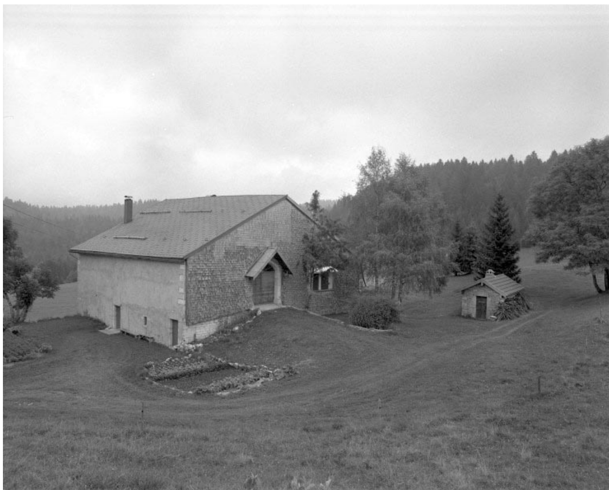
Façade postérieure et face gauche recouverte d'un essentage de tavaillons, le fournil est à droite.
