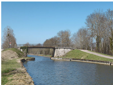
Le pont. Phot. Thierry Kuntz IVR26_20122102740NUC4A
