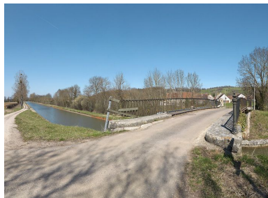
Le pont. Phot. Thierry Kuntz IVR26_20122102742NUC4A
