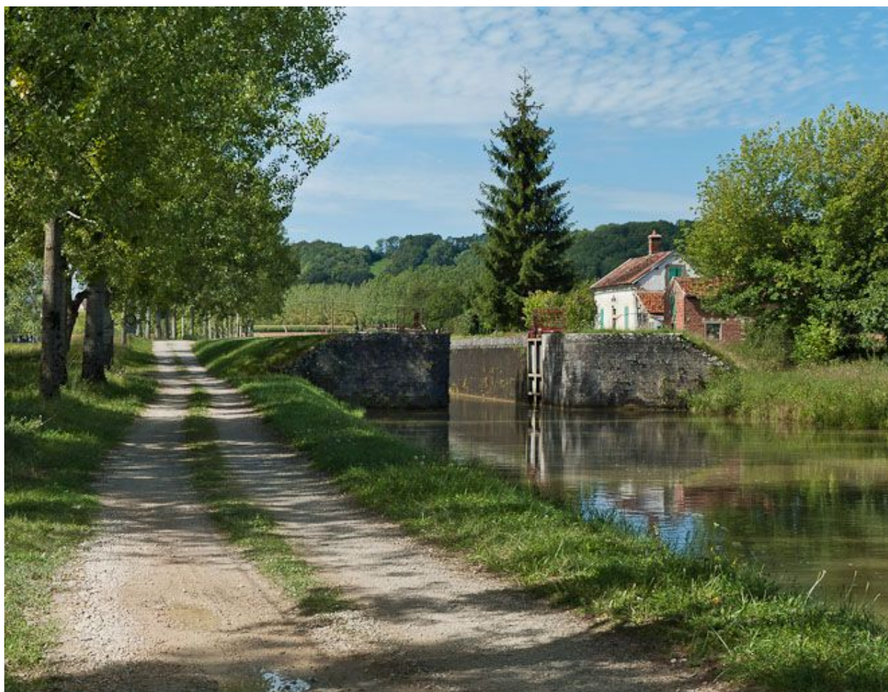
Vue du site d'écluse depuis l'aval.
