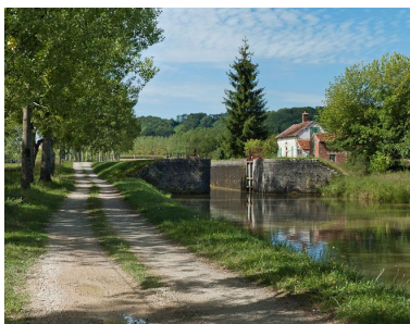
Vue du site d'écluse depuis l'aval. Phot. Pierre-Marie Barbe-Richaud IVR26_20112103873NUC4AQ
