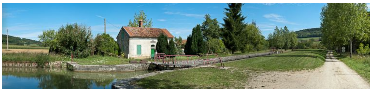
Vue d'ensemble du site d'écluse.
