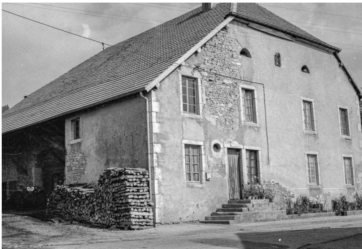
Façades antérieure et latérale gauche.
