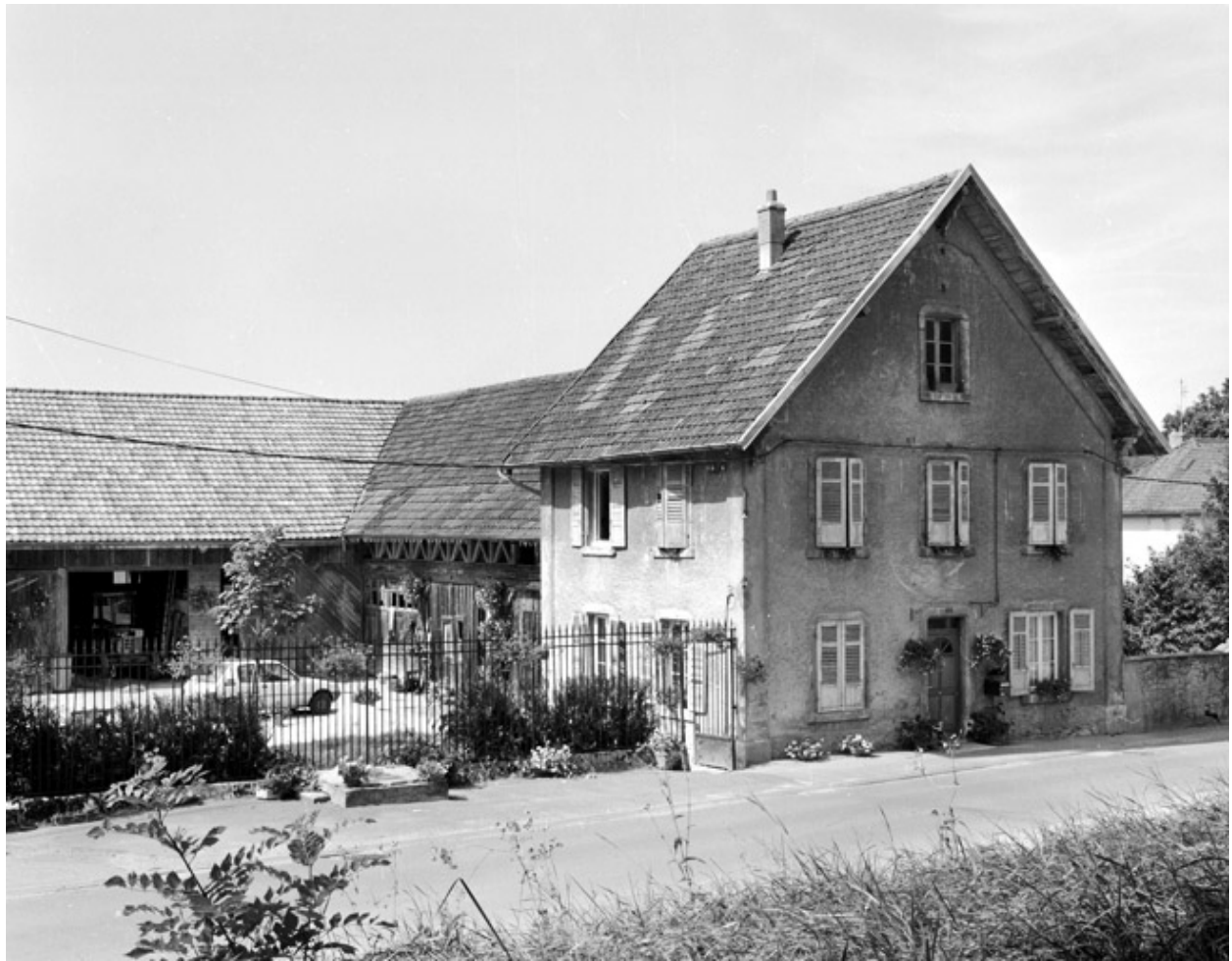
L'aile nord et le logement.
