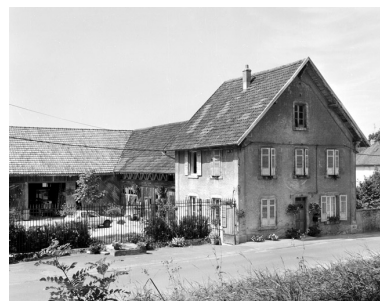
L'aile nord et le logement. Phot. Yves Sancey IVR43_20019000477X
