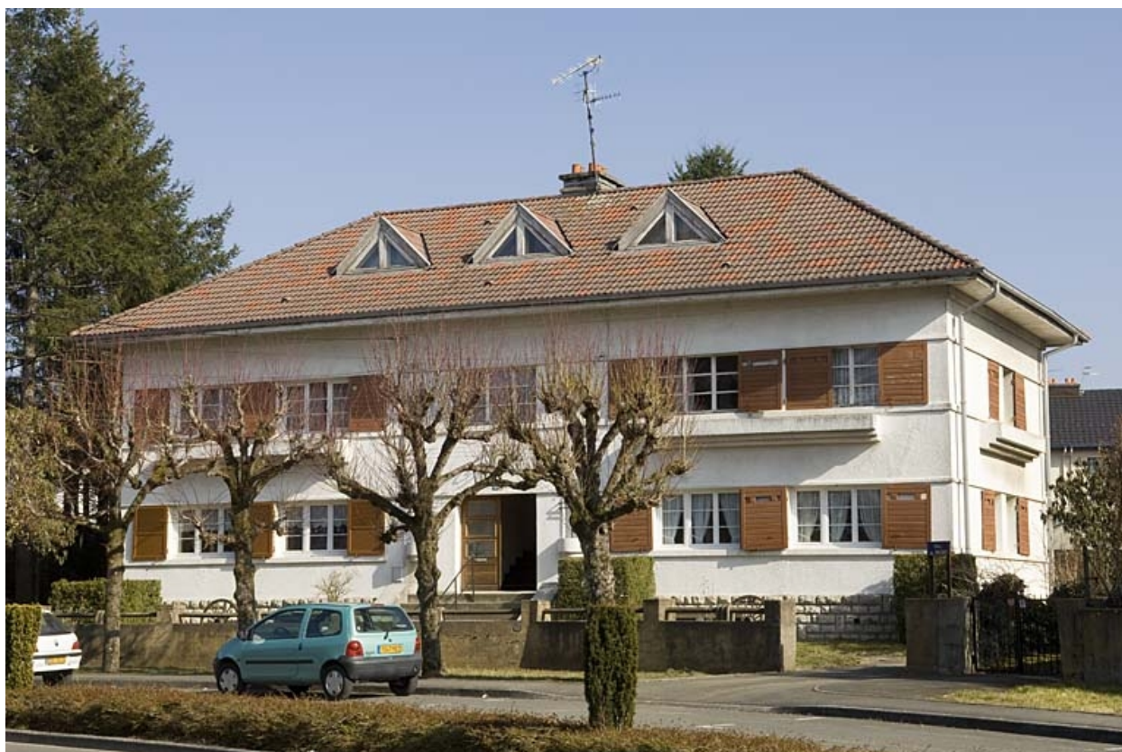
Maison de contremaîtres.
