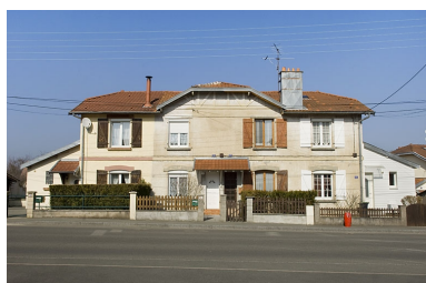
Habitation à 4 logements. Vue de face. Phot. Marc Loukachine IVR43_20122500259NUC2A
