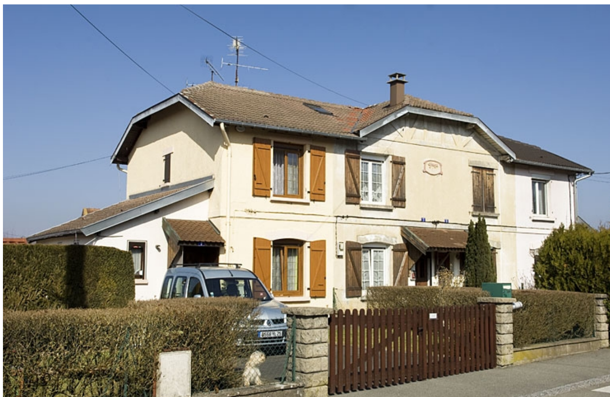
Habitation à 4 logements. Vue de trois quarts.
