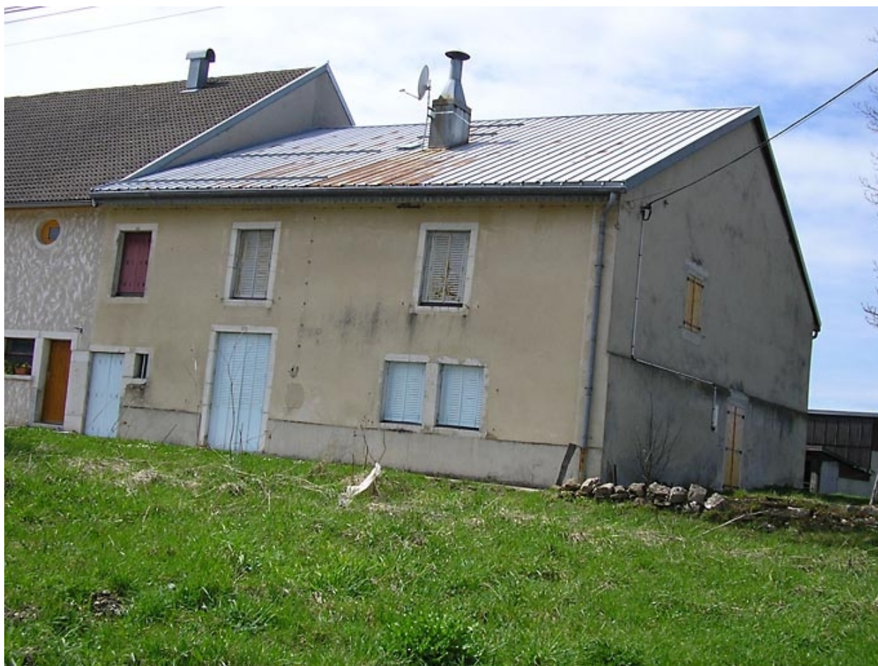
Façade postérieure et pignon sud-ouest.
