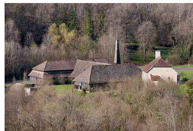
Vue plongeante depuis le nord-est.
