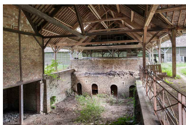
Aire d'enfournement et gueules de charge des fours. Phot. Jérôme Mongreville IVR43_20152501887NUC4A
