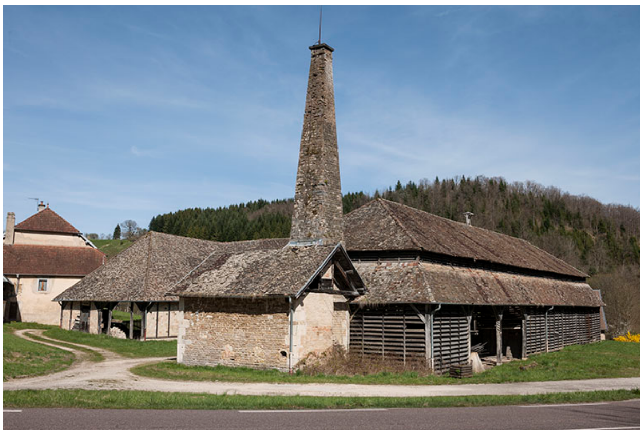
Vue rapprochée depuis le sud-ouest.
