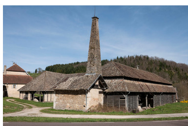
Vue rapprochée depuis le sud-ouest.
