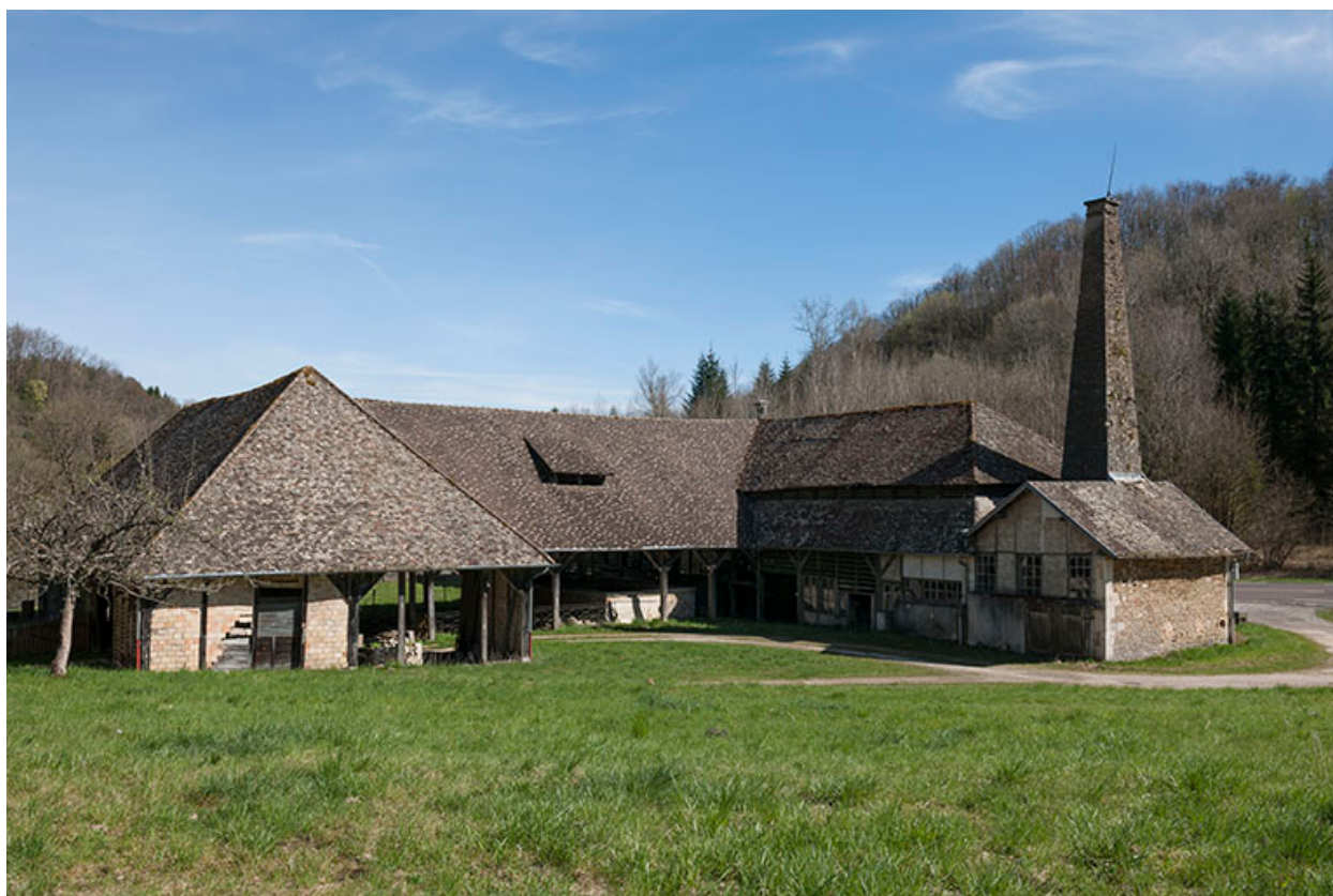
Vue rapprochée depuis le nord-ouest.
