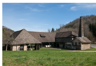
Vue rapprochée depuis le nord-ouest.
