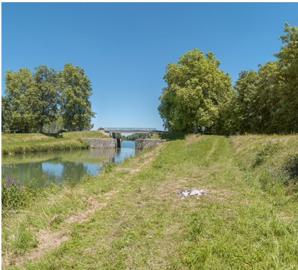
Vue d'ensemble d'aval.
