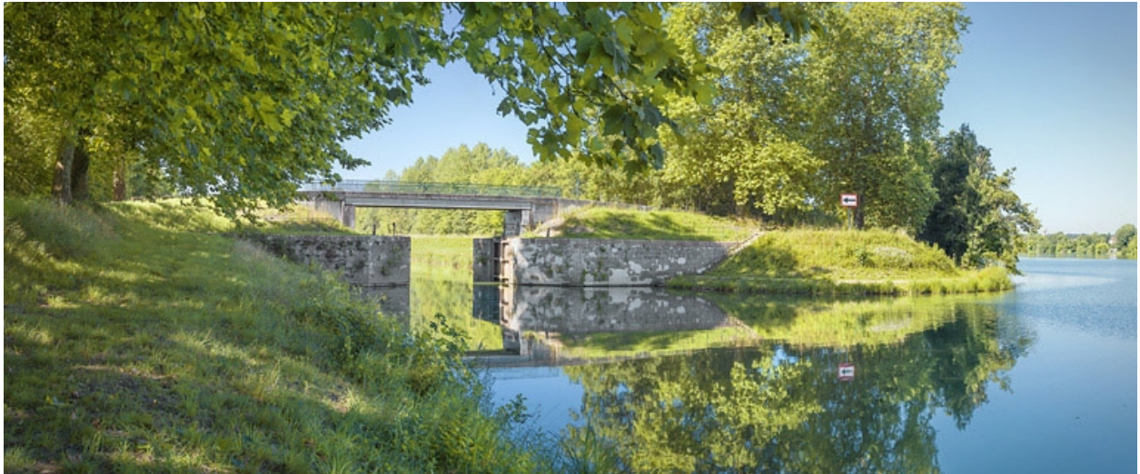
Vue d'ensemble d'amont.
