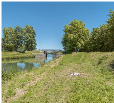
Vue d'ensemble d'aval. Phot. Thierry Kuntz IVR26_20162101314NUC4A
