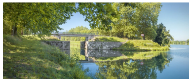
Vue d'ensemble d'amont. Phot. Thierry Kuntz IVR26_20162101313NUC4A
