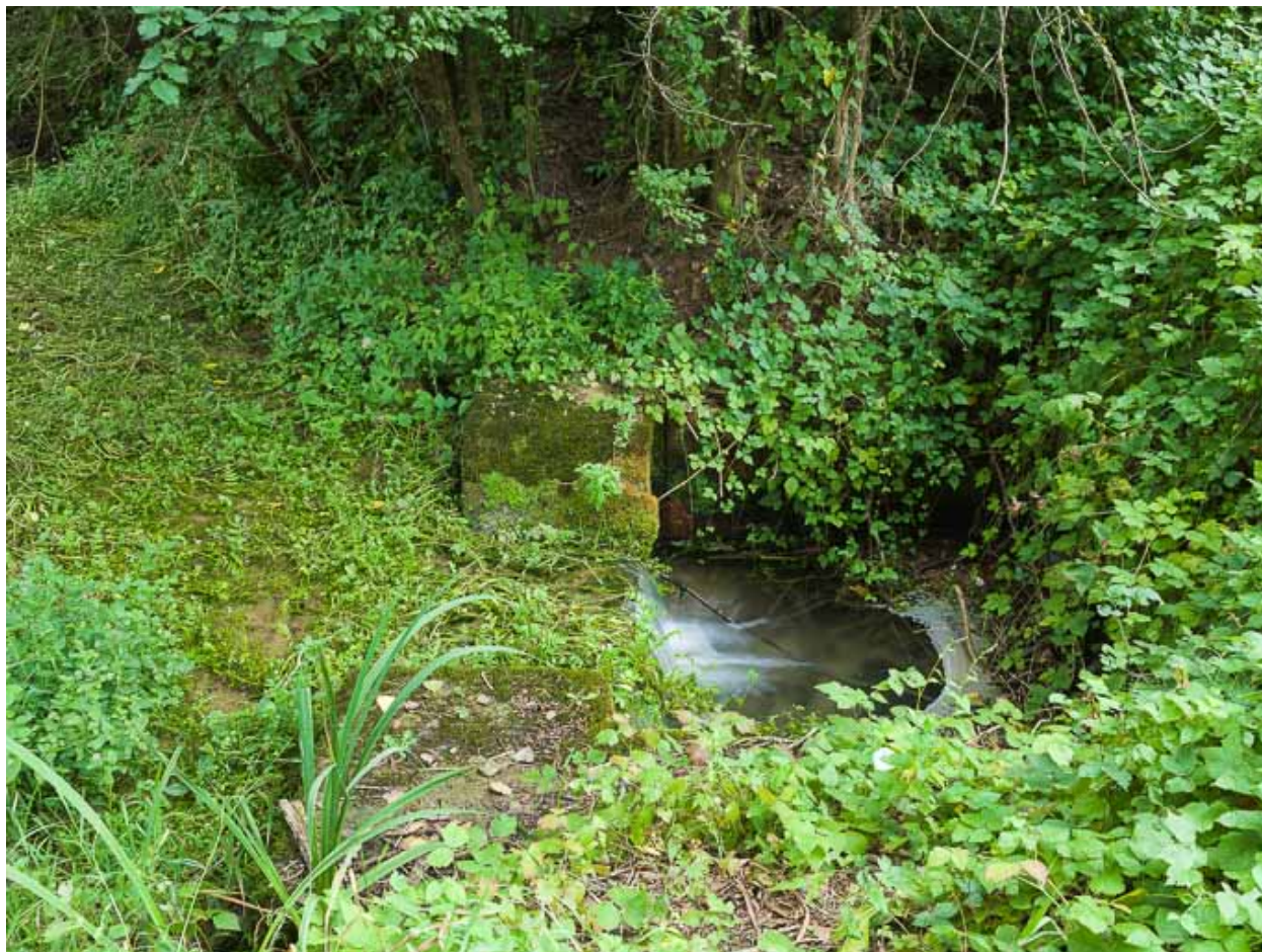
Vue de l'aqueduc dans la végétation.
