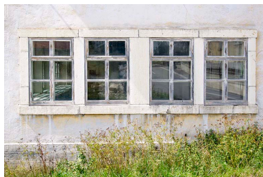
Une fenêtre multiple ou "fenestration" : usine d'ébauches de montre et de fournitures pour l'horlogerie Aster Frésard (6 rue des Lilas). Phot. Sonia Dourlot IVR43_20152500975NUC2A
