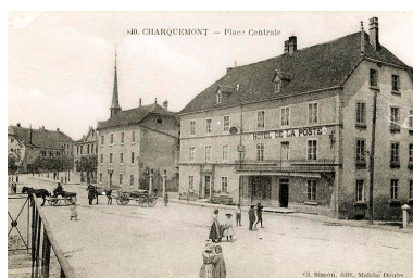
Place de l'Hôtel de Ville, avec les entreprises d'horlogerie Binétruy puis Maillot (n° 2-3) et Binétruy puis Perrot (hôtel de la Poste, n° 5-6) : 840. Charquemont - Place centrale, 1er quart 20e siècle (avant 1917). Autr. Charles Simon
