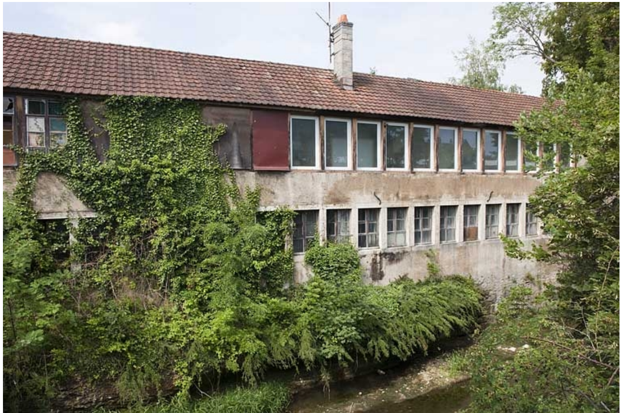
Façade sur le Gland de l'atelier d'horlogerie.
