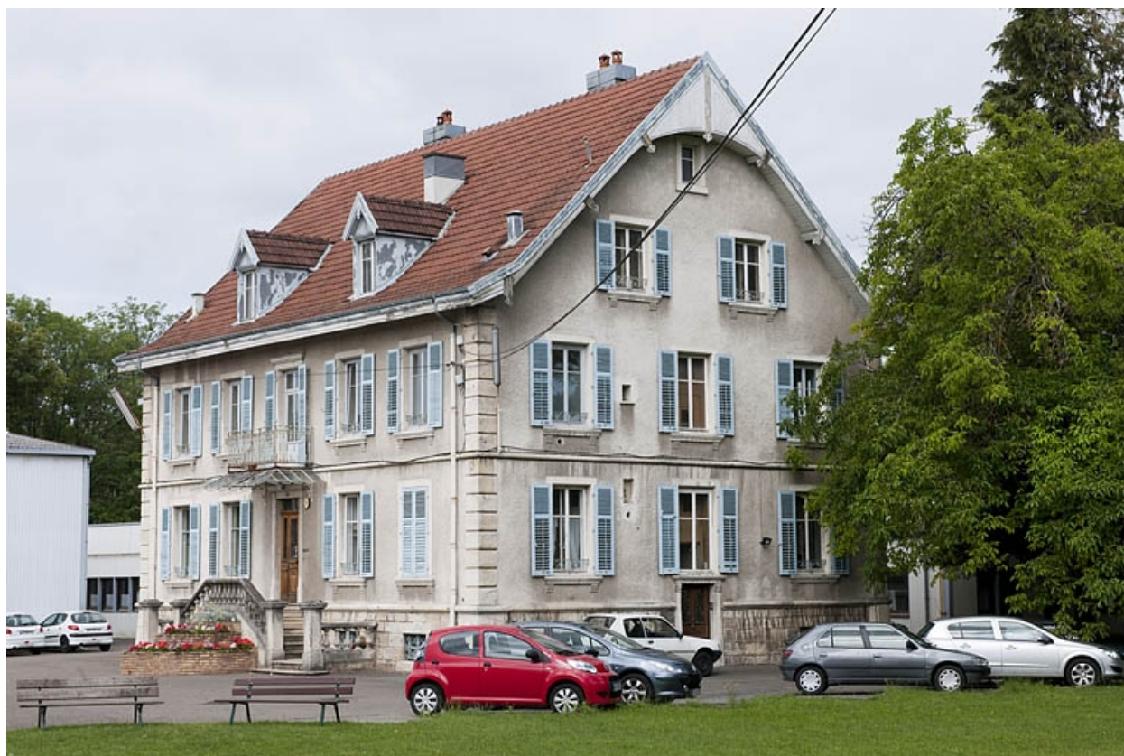
Logement patronal vu de trois quarts.
