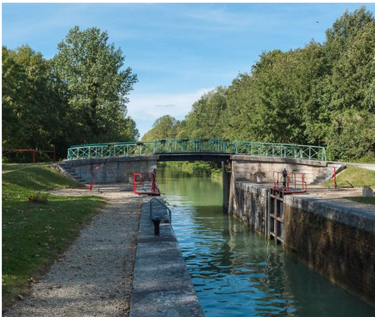
Vue du pont depuis le sas.
