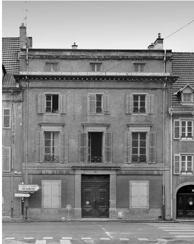
Façade sur rue. Phot. Jérôme Mongreville IVR43_19872501076V
