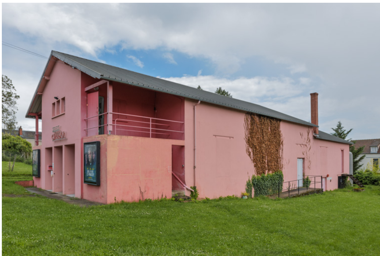
Façades antérieure et latérale droite.
