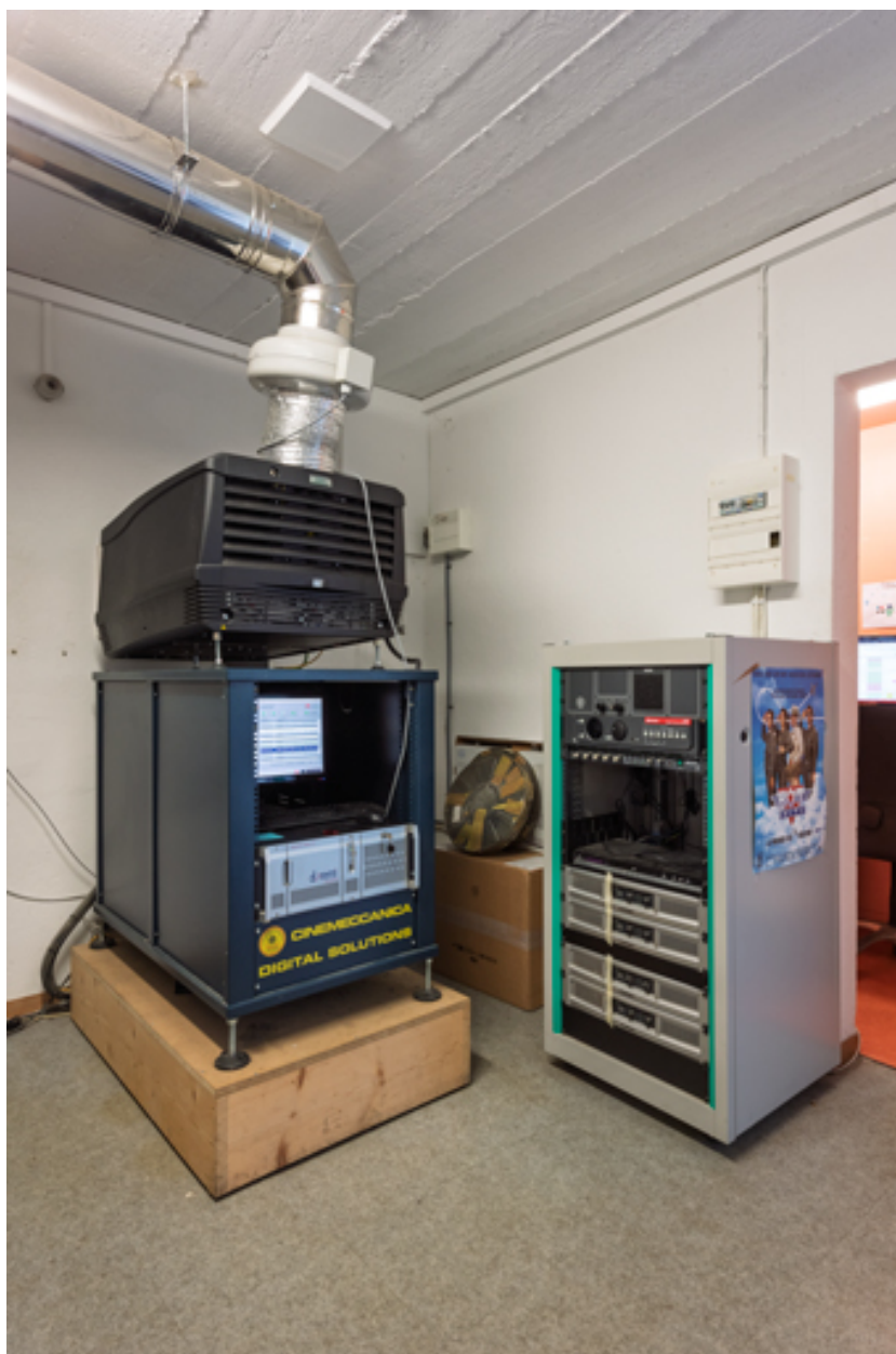
Cabine de projection : projecteur numérique Barco DP2K-15C.
