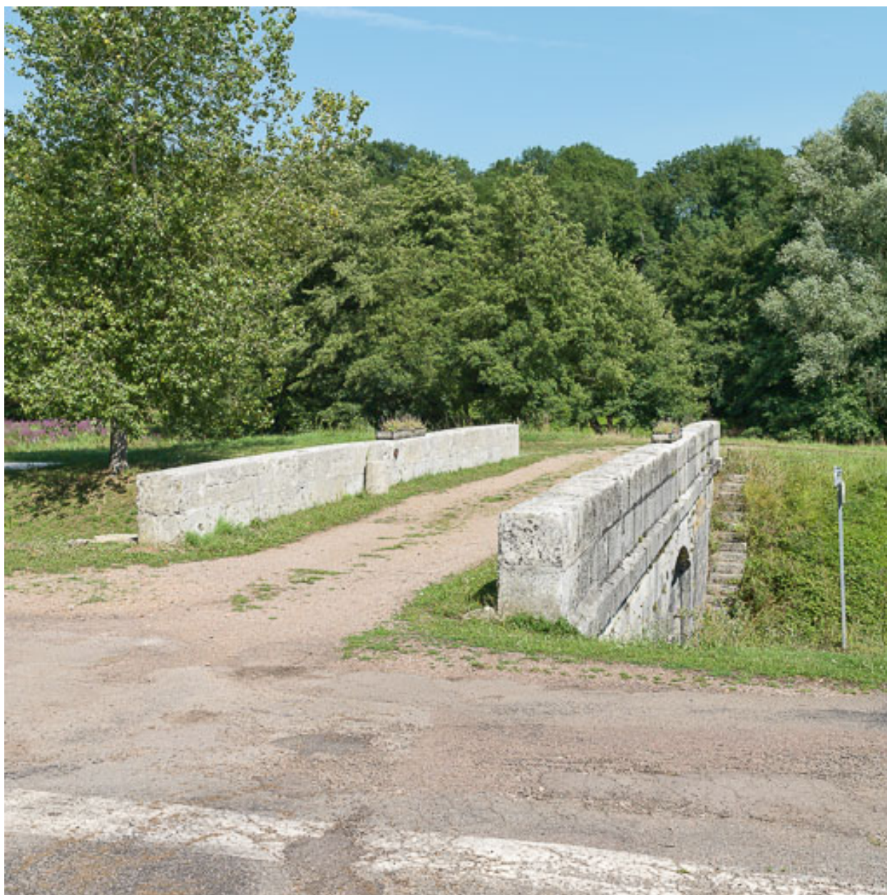
Vue du pont.
