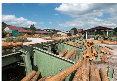
Scierie Boillot : vue partielle des installations. Phot. Sonia Dourlot IVR43_20172501068NUC4A
