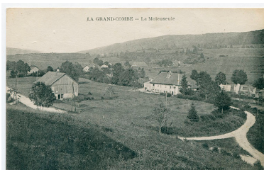
La Grand-Combe - La Moieuseule, 1ère moitié 20e siècle. La scierie Droz (puis Burgunder) correspond au bâtiment à droite. Autr. auteur inconnu IVR43_20172501529NUC4A
