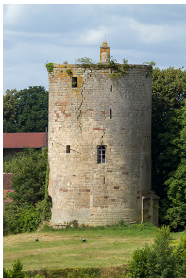
Vue générale. Phot. Sonia Dourlot IVR43_20157001255NUC2A
