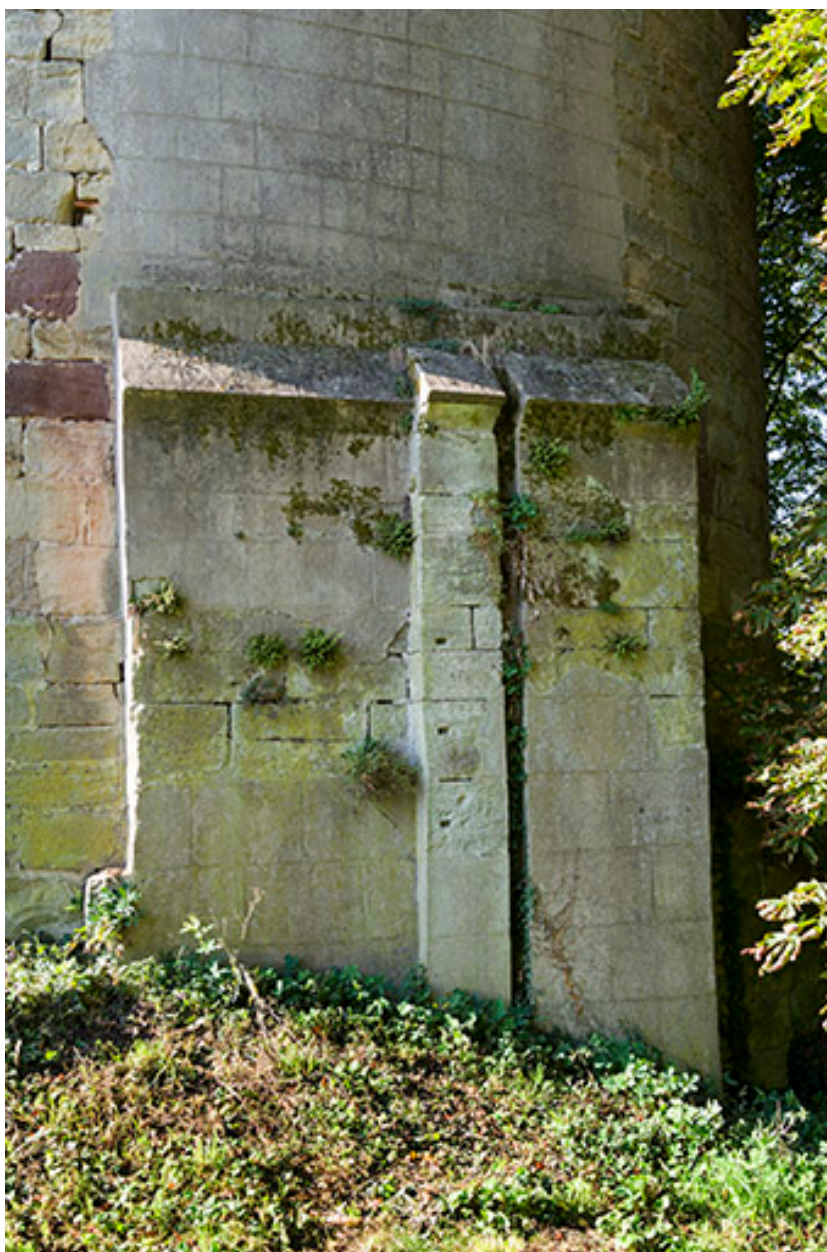
Emplacement probable d'une ancienne porte.
