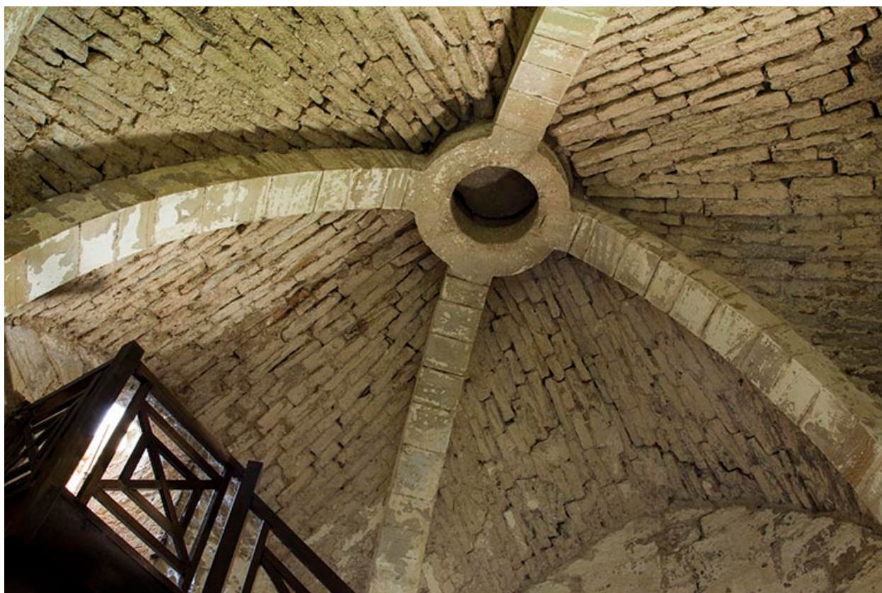
Le plafond voûté du rez-de-chaussée du donjon.
