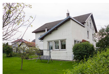
Maison au 12 Grande Rue : atelier de 1914. Phot. Yves Sancey IVR43_20132501322NUC2A
