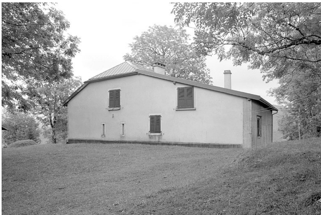
Façade postérieure de la fromagerie.
