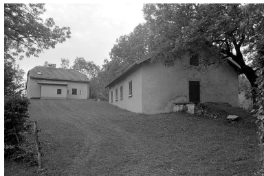
Vue de l'ensemble des bâtiments. Phot. Jérôme Mongreville IVR43_19963901264X
