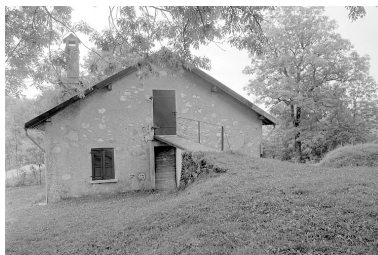
Face sud-ouest de la porcherie. Phot. Jérôme Mongreville IVR43_19963901265X
