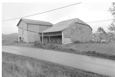
Façade postérieure et face ouest. Phot. Jérôme Mongreville IVR43_19963901505X
