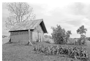
Le grenier fort aux côtés de la ferme. Phot. Jérôme Mongreville IVR43_19963901499X
