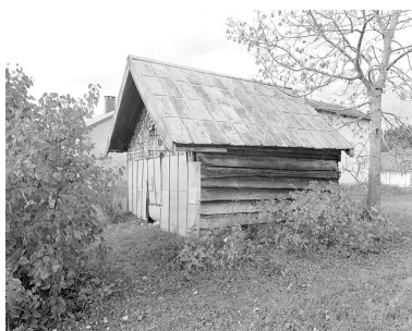
Le grenier fort. Phot. Jérôme Mongreville IVR43_19963901500X
