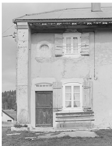
Façade antérieure, accès au logis. Phot. Jérôme Mongreville IVR43_19963901508X
