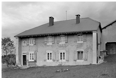
Façade antérieure. Phot. Jérôme Mongreville IVR43_19963901502X
