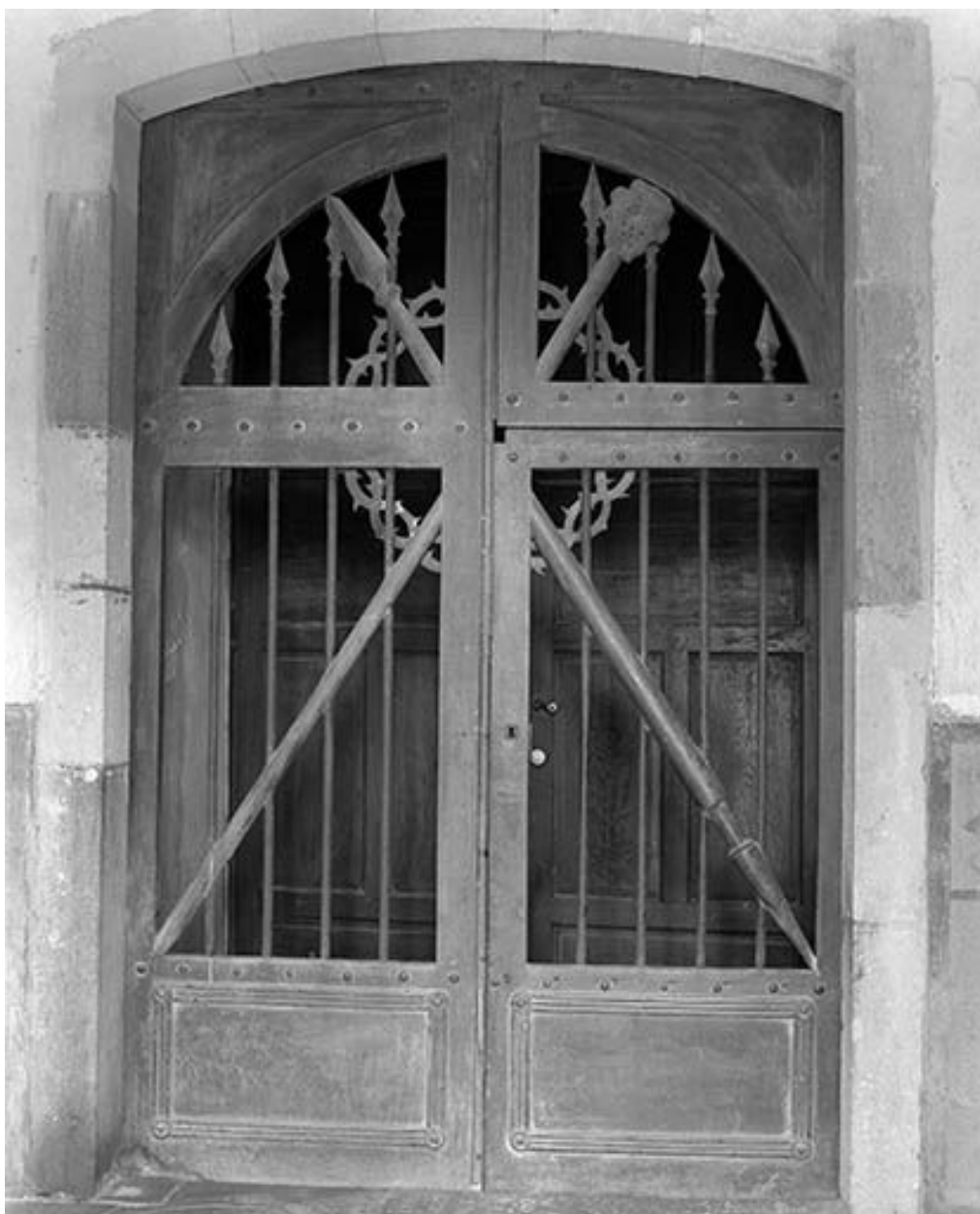
Porte conduisant à la nef.
