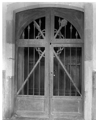
Porte conduisant à la nef. Phot. Yves Sancey IVR43_19762501008X
