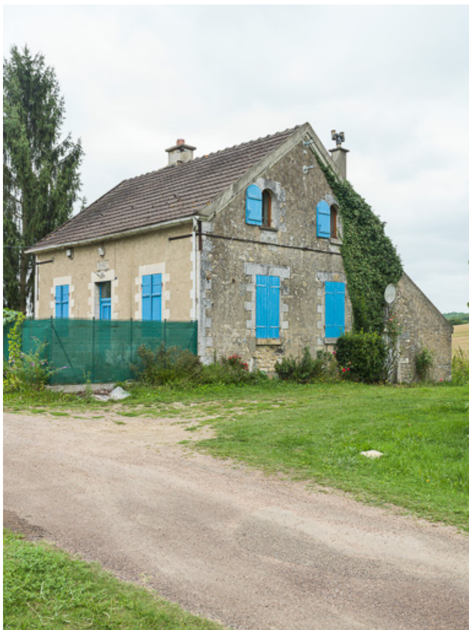
Vue de la maison éclusière.
