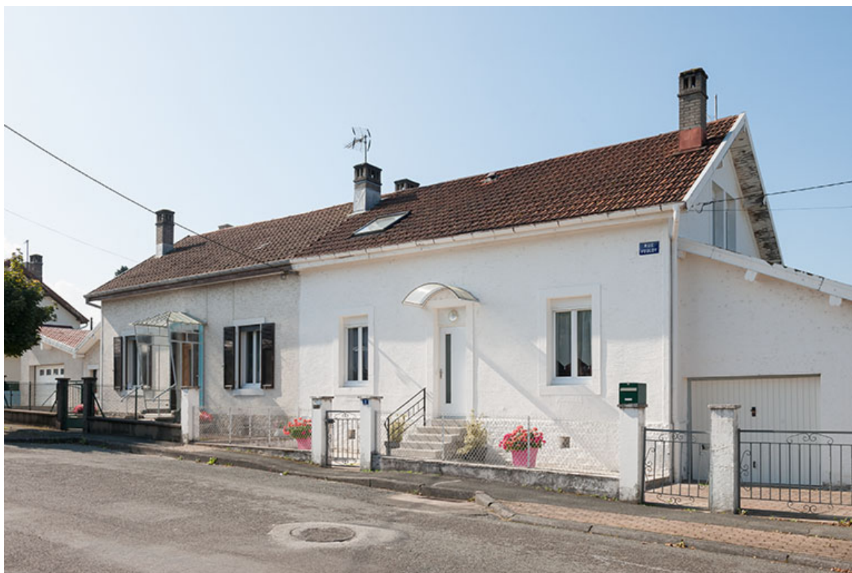
Maison jumelée vue de trois quarts droite.
