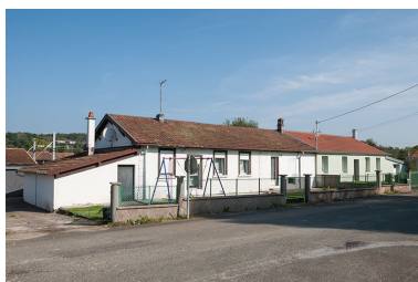
Habitation en rez-de- chaussée (3 logements). Phot. Jérôme Mongreville IVR43_20142501364NUC4A
