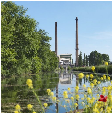
Vue générale de l'usine depuis l'embranchement. Phot. Thierry Kuntz IVR26_20137100271NUC4A
