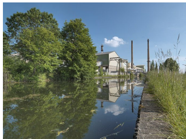
L'embranchement avec l'usine Véralia. Phot. Thierry Kuntz IVR26_20137100267NUC4A
