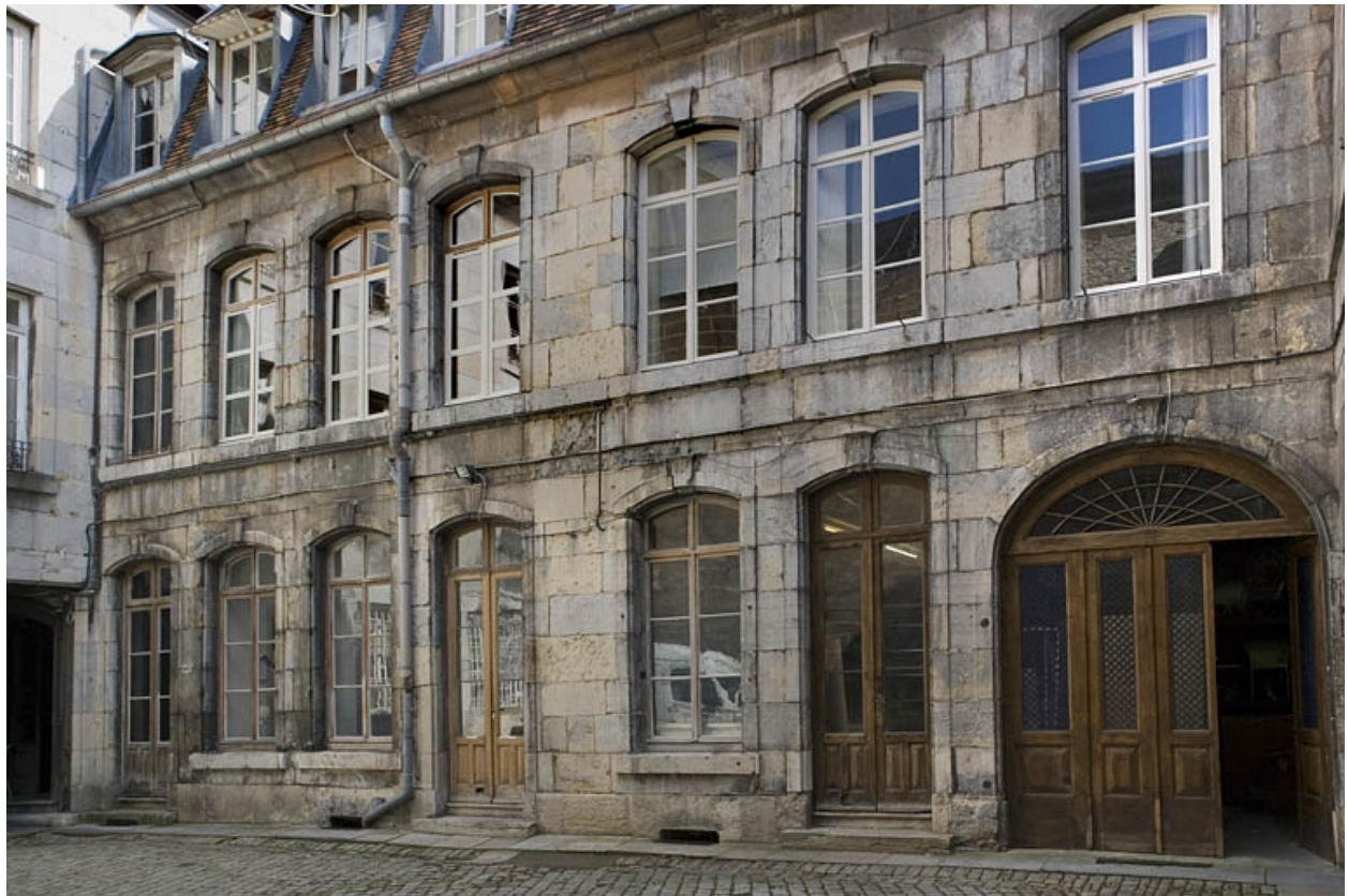
Vue d'ensemble de l'aile gauche sur cour.
